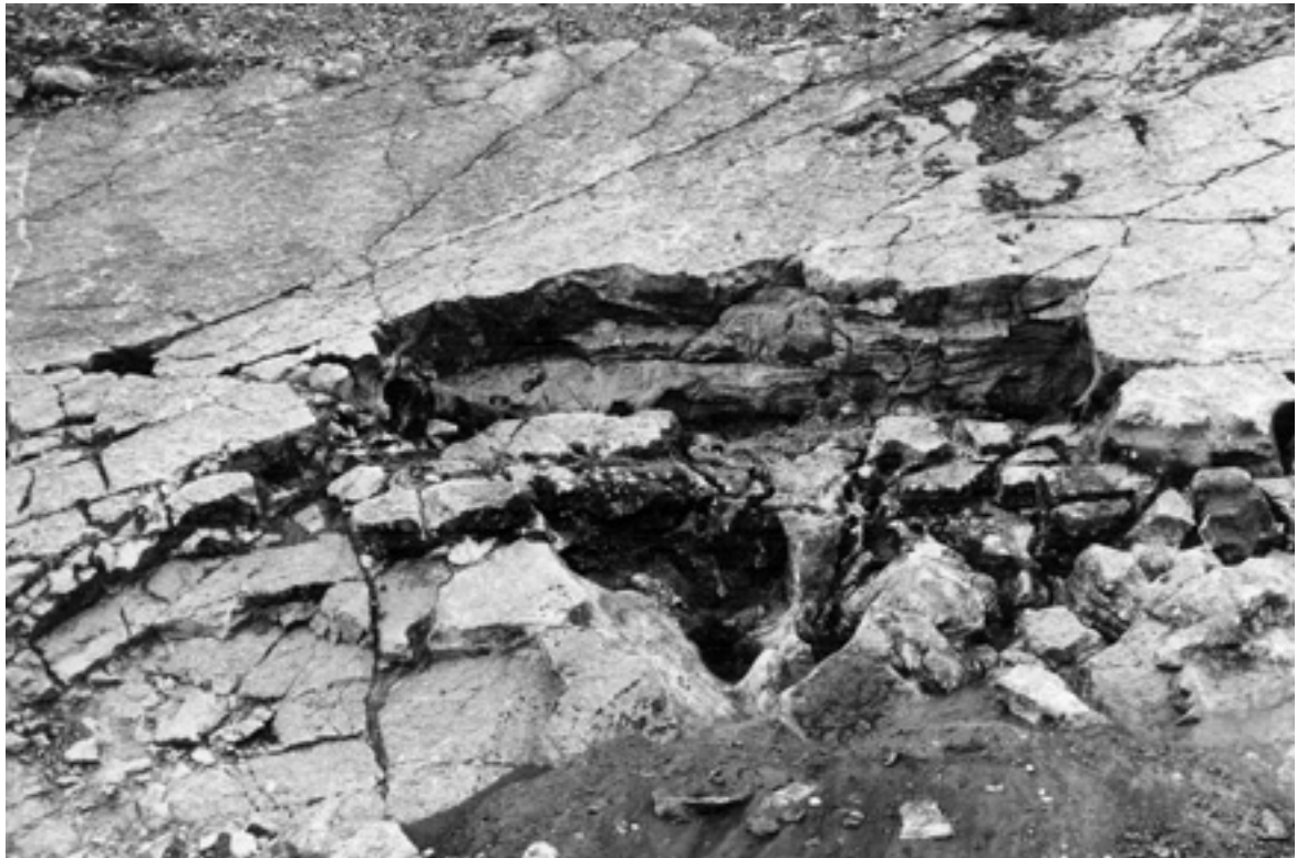
Fig. 8 – Vista da galeria, no final dos trabalhos. Foto de M. Leitão.
