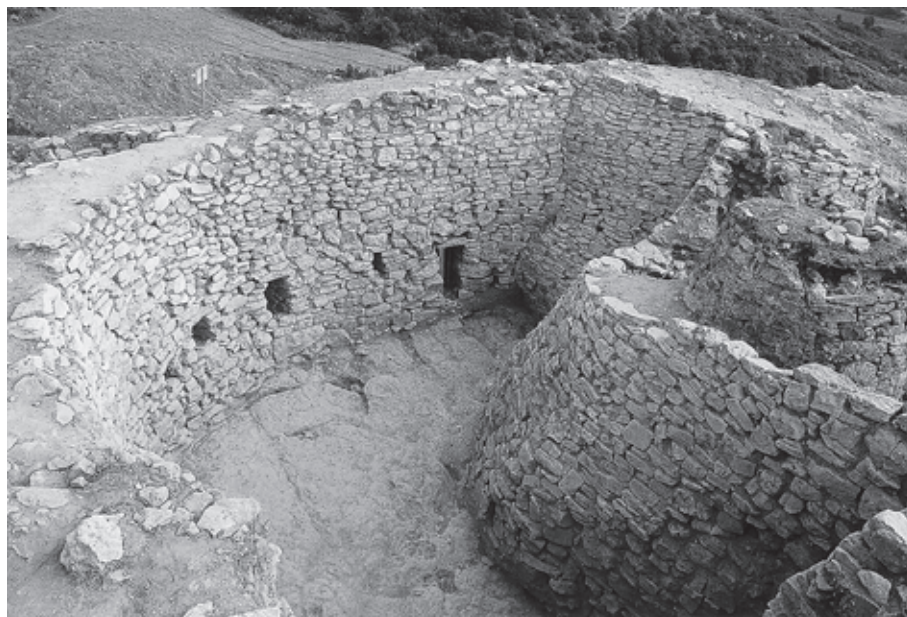
Fig. 17 —Recinto interior (“barbacã” ou “baluarte”) existente na fortificação central do povoado calcolítico do Zambujal, onde as frestas observáveis foram interpretadas como seteiras, abertas para o exterior, para espaço delimitado por outra linha defensiva. Arquivo M. Farinha dos Santos.
