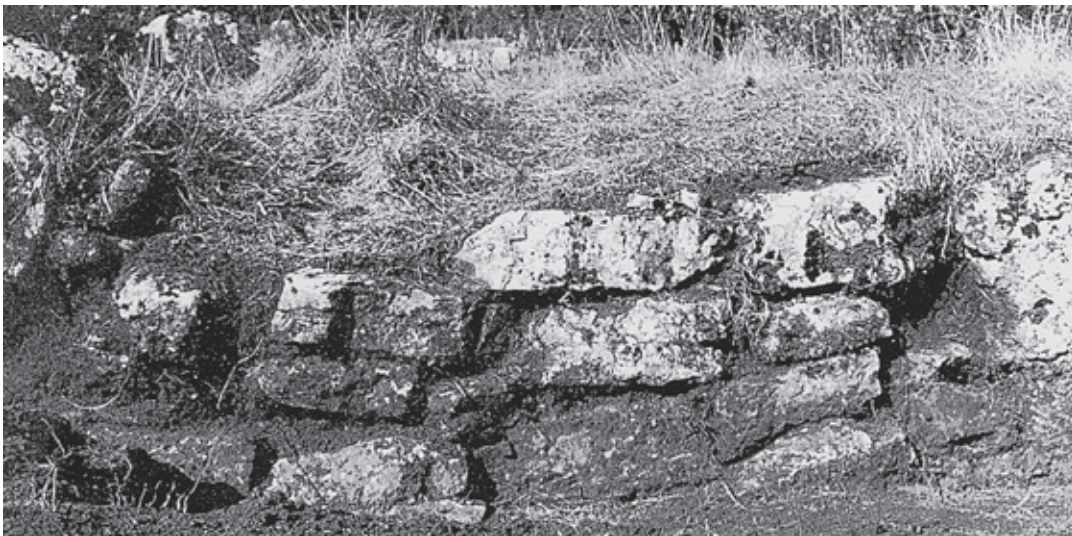
Fig. 48 – Povoado calcítico da Fórnea, Torres Vedras. Pormenor do aparelho construtivo da muralha. Seg. K. Spindler & G. Gallay.
