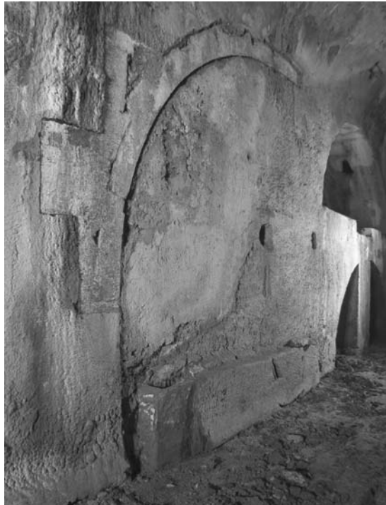
Fig. 8 – Um outro arco, não figurado no desenho de Turriano, foi também localizado e posto a descoberto. Trata-se do terceiro arco das Ferrarias, em posição coincidente com a localização do engenho de verrumar (ver Fig. 11), proposto para a introdução da fabricação de armas de fogo. A construção desse espaço, anexo ao edifício original, terá ditado o tapamento do referido arco.
