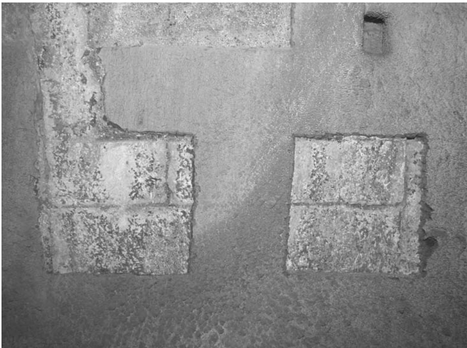
Fig. 7 – Pormenor de uma das áreas de picagem. Observa-se o arranque do arco bem como a largura do pilar de alvenaria de pedra que o suportava. Confirmou-se a qualidade da planta levantada por Leonardo Turriano, cerca de 1617/1618. Note-se a crosta dura e amarelada, cobrindo uniformemente a superfície da galeria, resultante da precipitação de carbonato de cálcio durante séculos.
