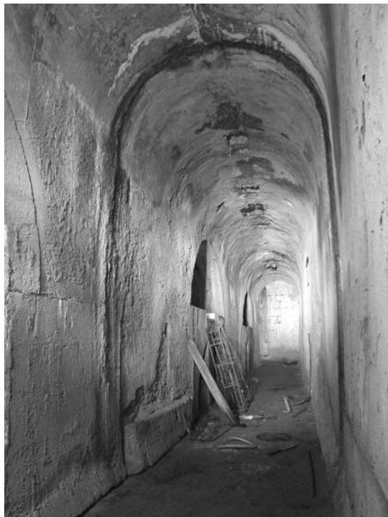
Fig. 1 – Aspecto da galeria das rodas hidráulicas da Fábrica de Cima, aquando do início da intervenção. O troço delimitado pela junta vertical, em primeiro plano, corresponde ao segmento mais antigo atribuído às Ferrarias de Barcarena.
