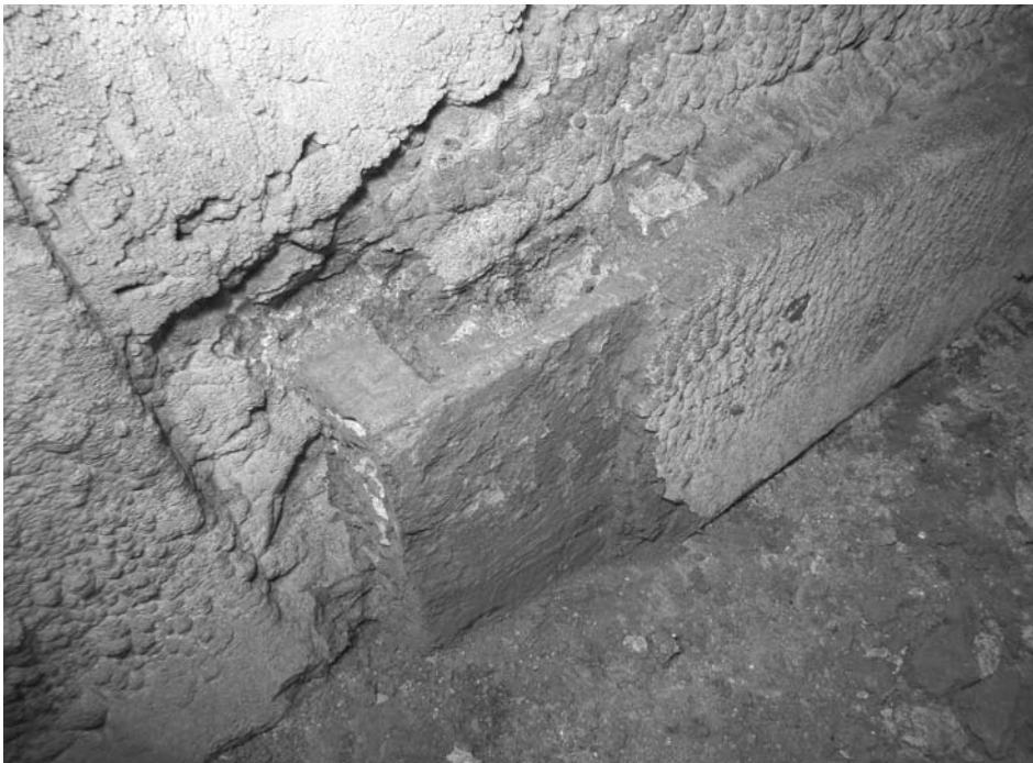
Fig. 9 – O último elemento localizado e por enquanto apenas parcialmente à vista. Parece tratar-se do topo de um tanque, provavelmente associado ao funcionamento do engenho de verrumar.
