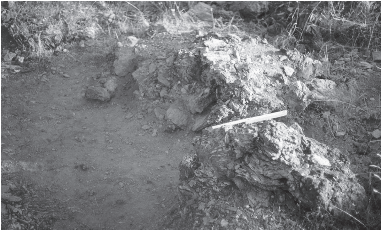
Fig. 4 - Troço da muralha (?) vitrificada (derrube no interior da fortificação).
