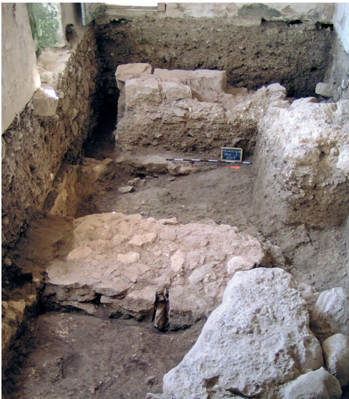
Fig. 3 – Vista geral da área escavada nas salas 2 e 3, depois da demolição da parede que as separava. Ao centro, o muro da Idade do Ferro já visível na Fig. 2, fundado em roço aberto no substrato geológico; em segundo plano, observa-se outro muro, mais moderno, da Idade do Ferro ou já de época romana, anterior à remodelação arquitectónica da pars urbana da villa correspondente à implantação do mosaico. Foto J. L. Cardoso.
