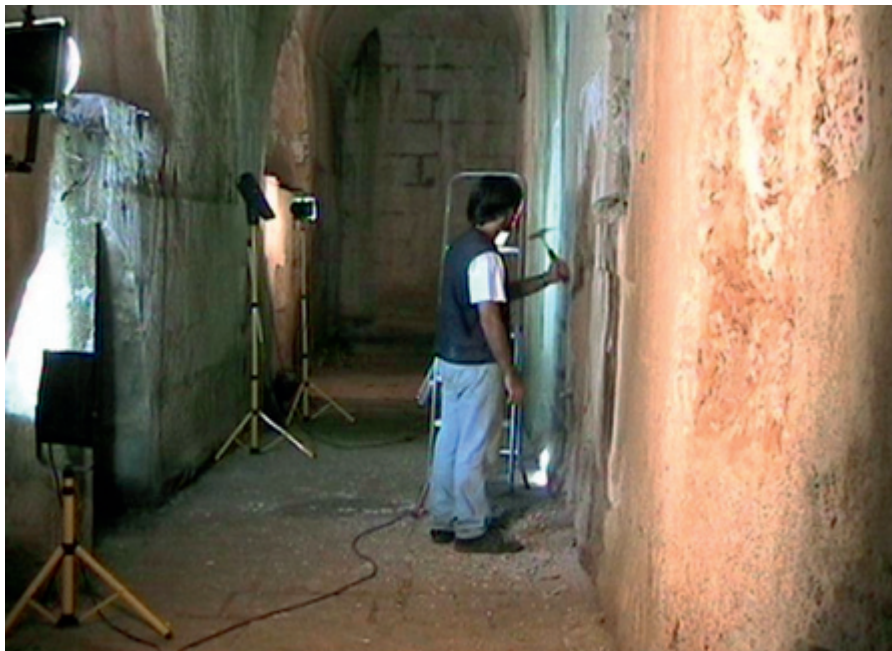
2006 – Vista parcial dos trabalhos de picagem de paredes realizados na galeria das rodas hidráulicas do edifício das Ferrarias del Rey, na Fàbrica da Pólvera de Barcarena, tendo em vista a identificação de pré-existências estruturais, visíveis na foto de cima.
