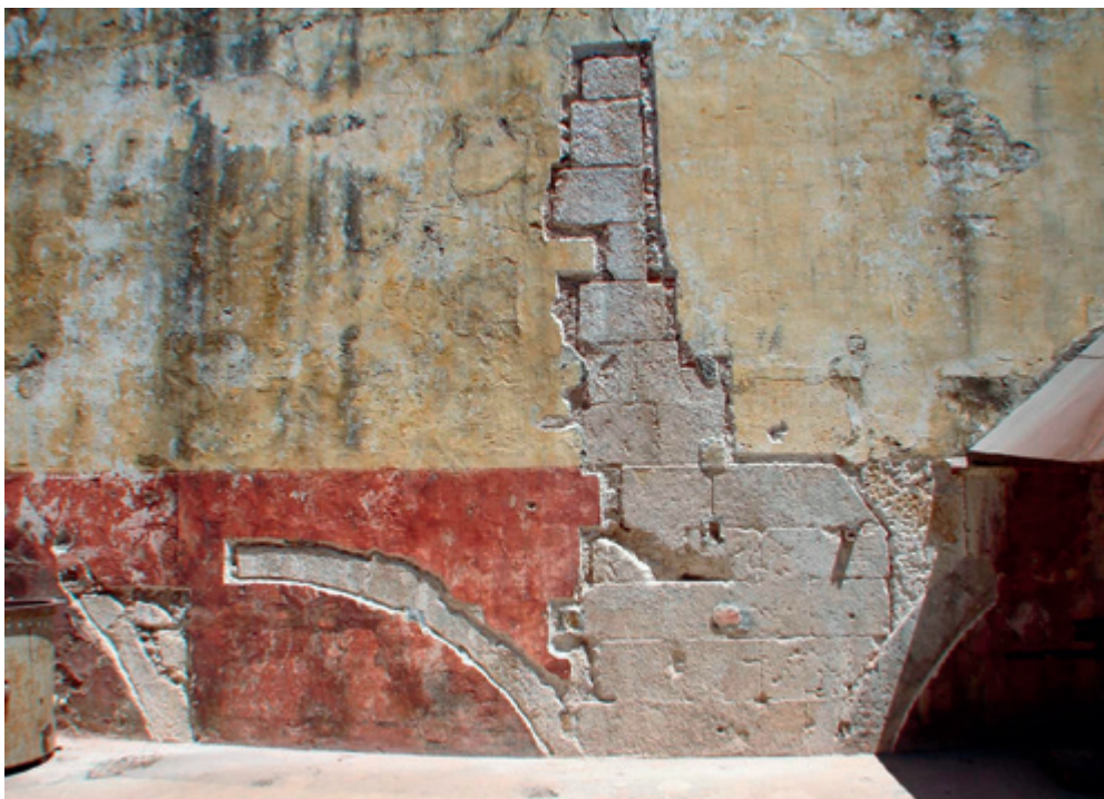
2007 – Perspectiva dos resultados dos trabalhos realizados no cunhal da galeria das rodas hidráulicas das Ferrarias d' El Rey, na Fábrica da Pólvora de Barcarena, evidenciando-se diversos elementos estruturais do edifício primitivo.
