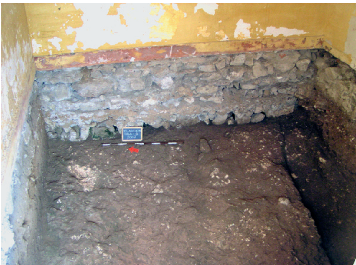
Fig. 5 – Vista parcial da escavação efectuada na Sala 4, observando-se ao fundo a fundação de uma das paredes mestras da casa setecentista, fundada no substrato geológico, em primeiro plano, o qual evidenciou um roço rectilíneo, correspondente à fundação de uma parede da Idade do Ferro, visível do lado direito. Foto J. L. Cardoso.
