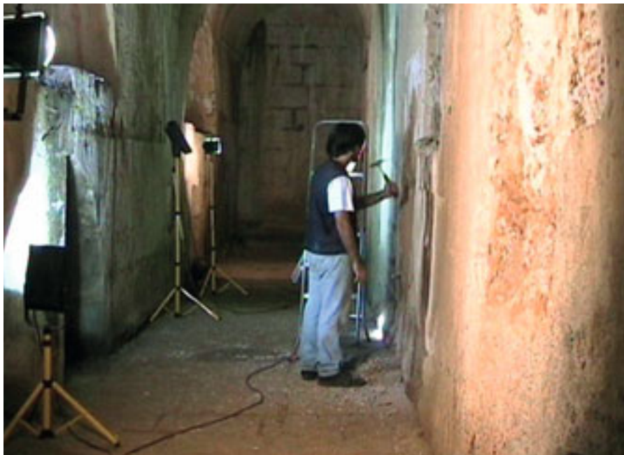
2006 – Vista parcial dos trabalhos de picagem de paredes realizados na galeria das rodas hidráulicas do edifício das Ferrarias del Rey, na Fábrica da Pólvora de Barcarena, tendo em vista a identificação de pré-existências estruturais, visíveis na foto de cima.
