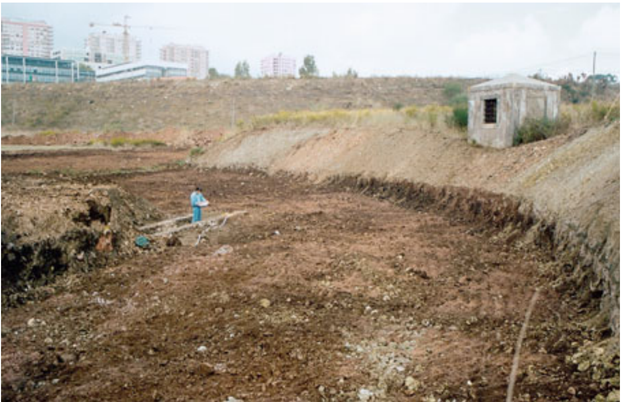
2002 – Intervenção preventiva no Parque de Santa Cruz – Aqueduto das Francesas (Carnaxide).
