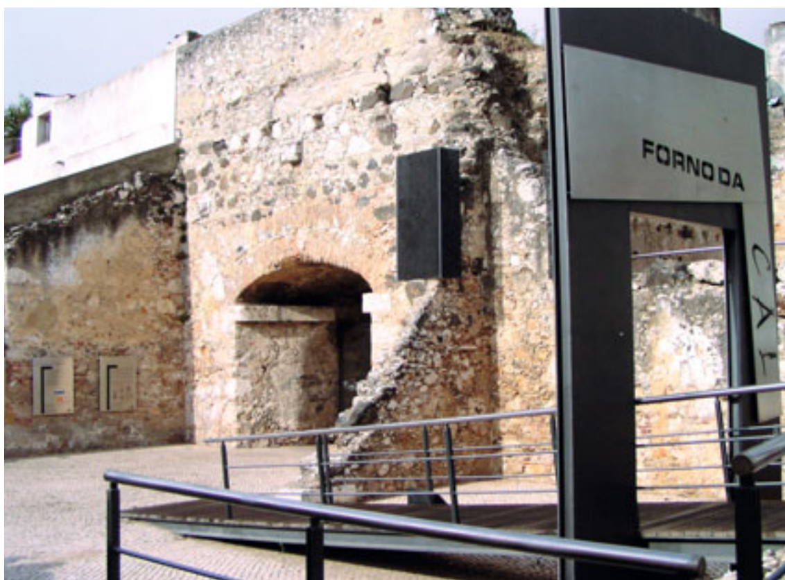
1995 – Escavações arqueológicas num dos Fornos da Cal de Paço de Arcos e seu aspecto actual, depois da recuperação efectuada.
