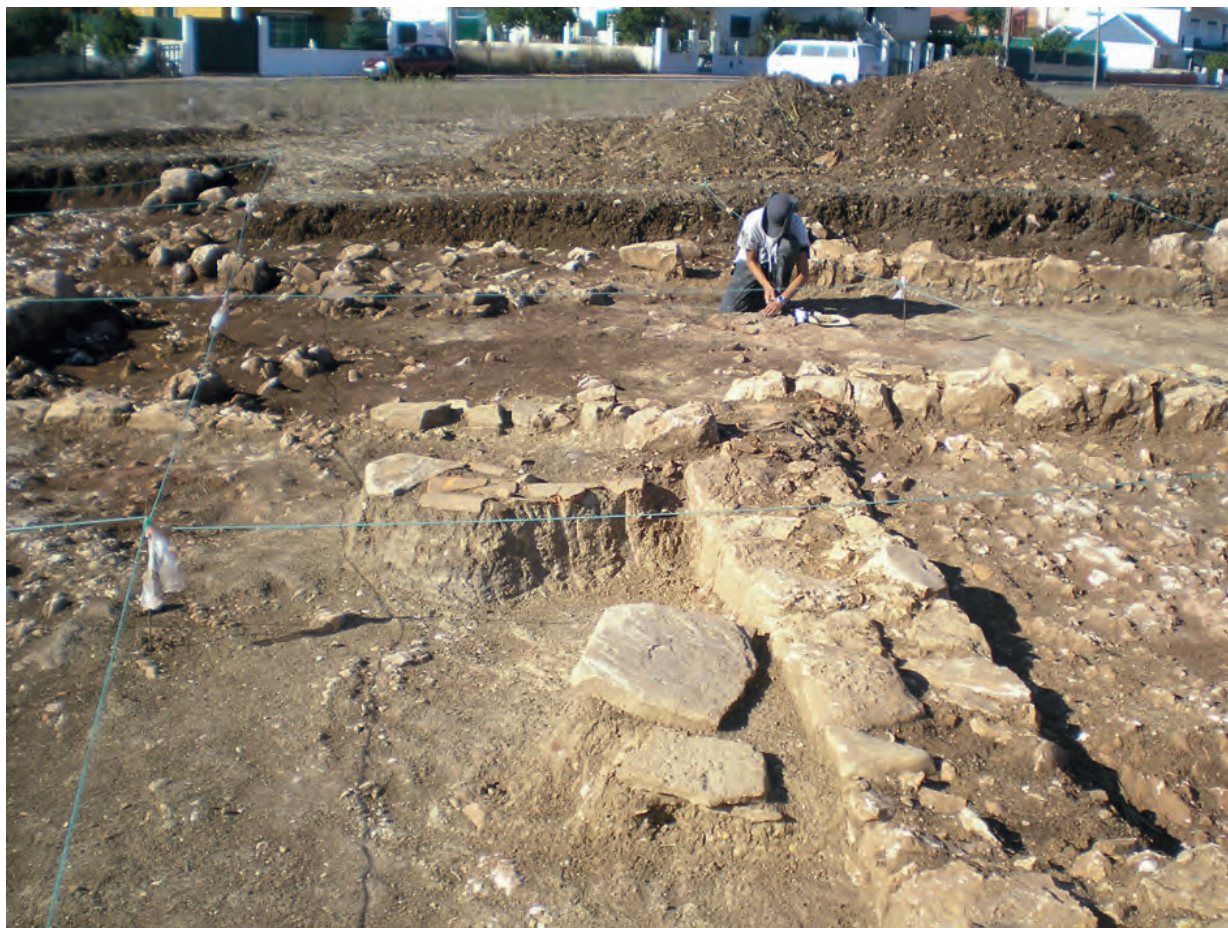
Fig. 19 – Leião. Vista parcial da área escavada. Em primeiro plano, testemunho do abatimento do telhado, constituído por imbrices dispostas horizontalmente, assentes directamente no piso de margas compactadas do Compartimento C. Em segundo plano, o Compartimento A, cujo interior continha um lar, assinalado pela figura humana. Foto J. L. Cardoso.
