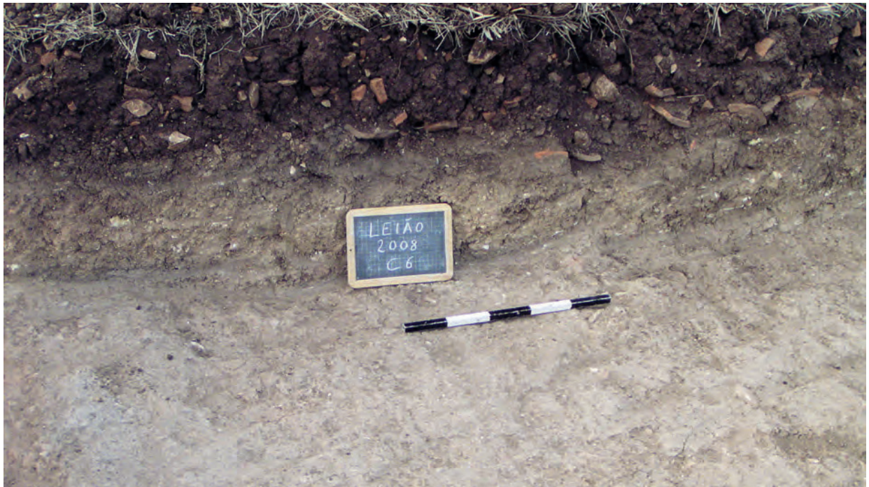
Fig. 11 – Leião. Corte no terreno, evidenciando-se o contacto da Camada 2 (solo arável), com a Camada 1 (margas compactadas correspondentes aos pisos dos diversos compartimentos do edifício). Foto J. L. Cardoso.
