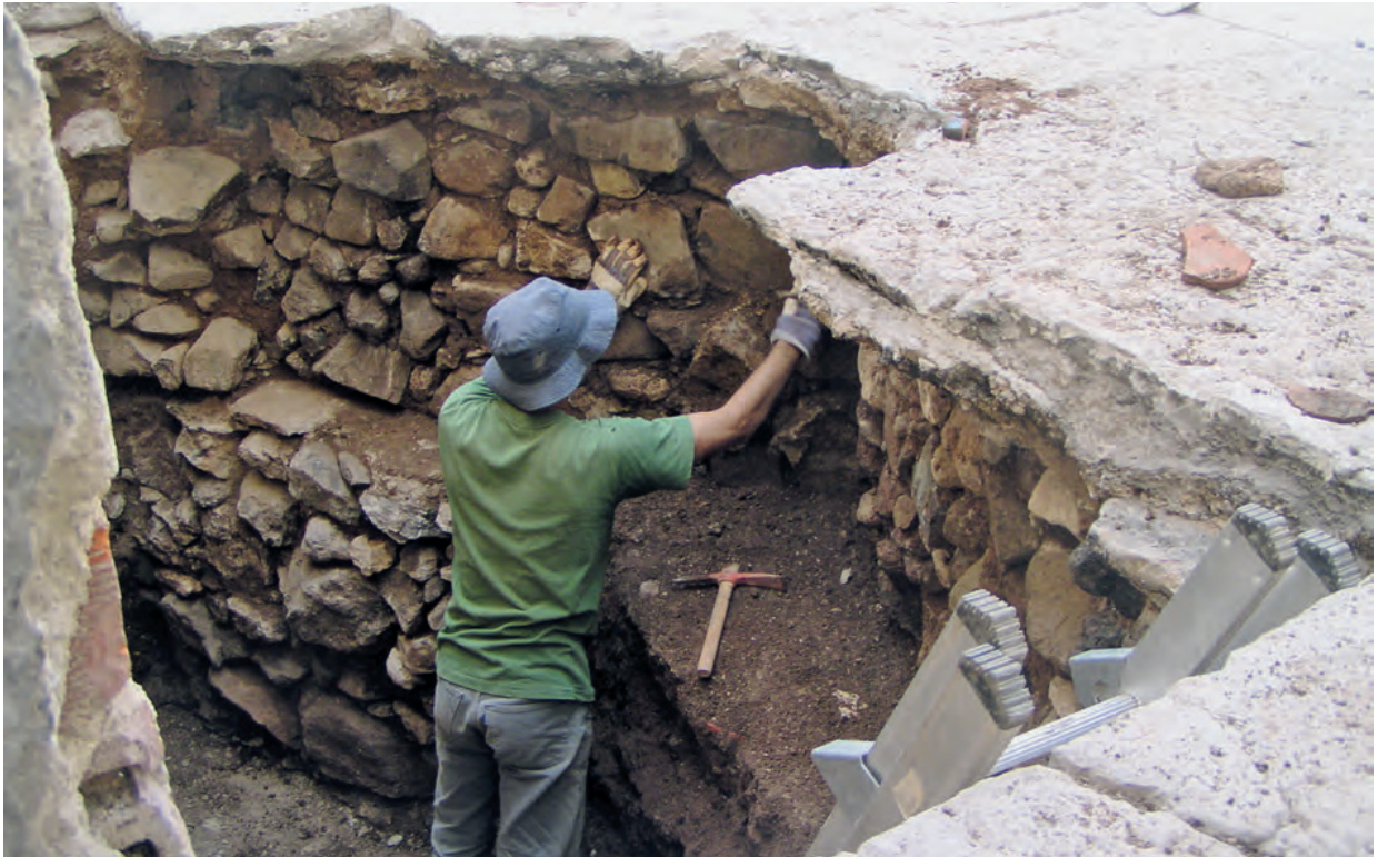
Fig. 12 – Ferrarias del Rey . Aspecto do revestimento externo da abóbada de alvenaria de suporte ao engenho de galgas, da fábrica da pólvora do século XVIII, enterrada sob o piso da oficina. Note-se as duas etapas construtivas, representadas pelo ressalto do revestimento do lado esquerdo da foto.
