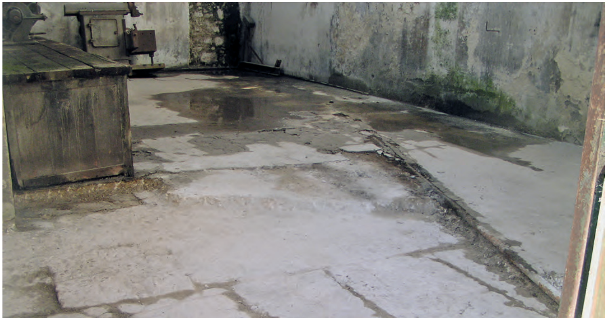
Fig. 9 – Ferrarias del Rey . Pormenor do chão primitivo da Oficina E do Edifício 33, depois de removida a camada de betonilha que o cobria.
