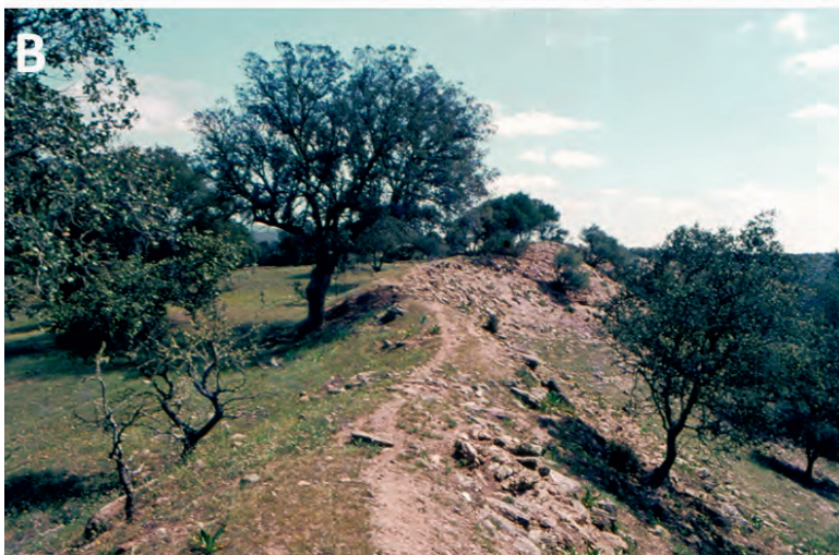
Fig. 10 – Dois aspectos de um troço de muralha, perpendicular ao rio Guadiana, do povoado da Crespa.
