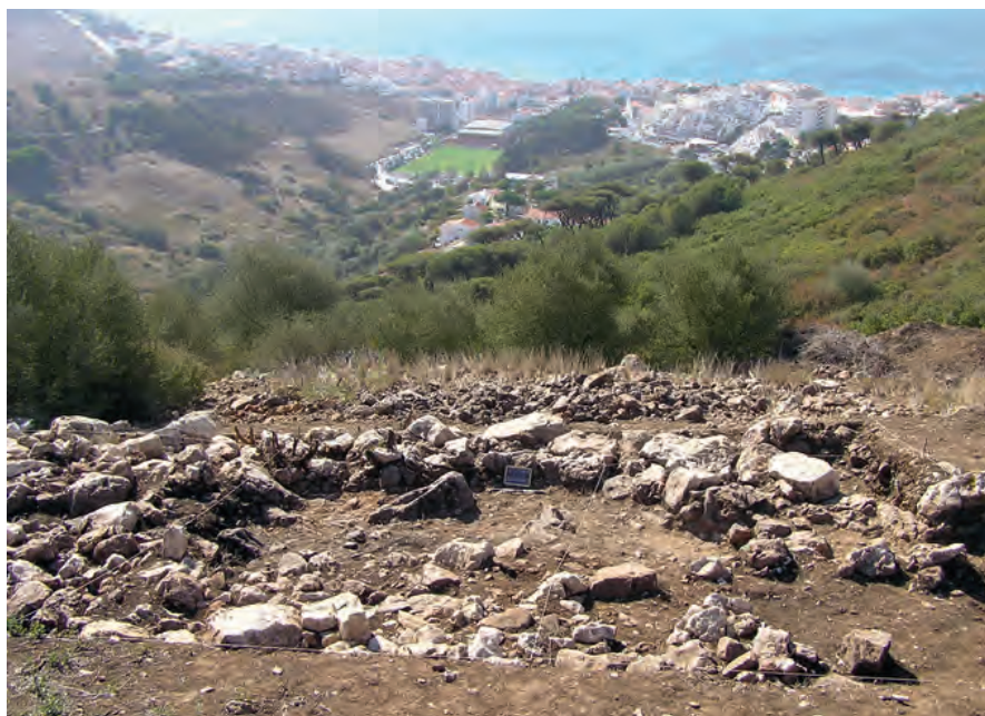
Fig. 9 – Outeiro Redondo. A estrutura C, voltada para sul, constituindo muro arqueado avançado em relação à muralha, podendo considerar-se como pequena barbacã.
