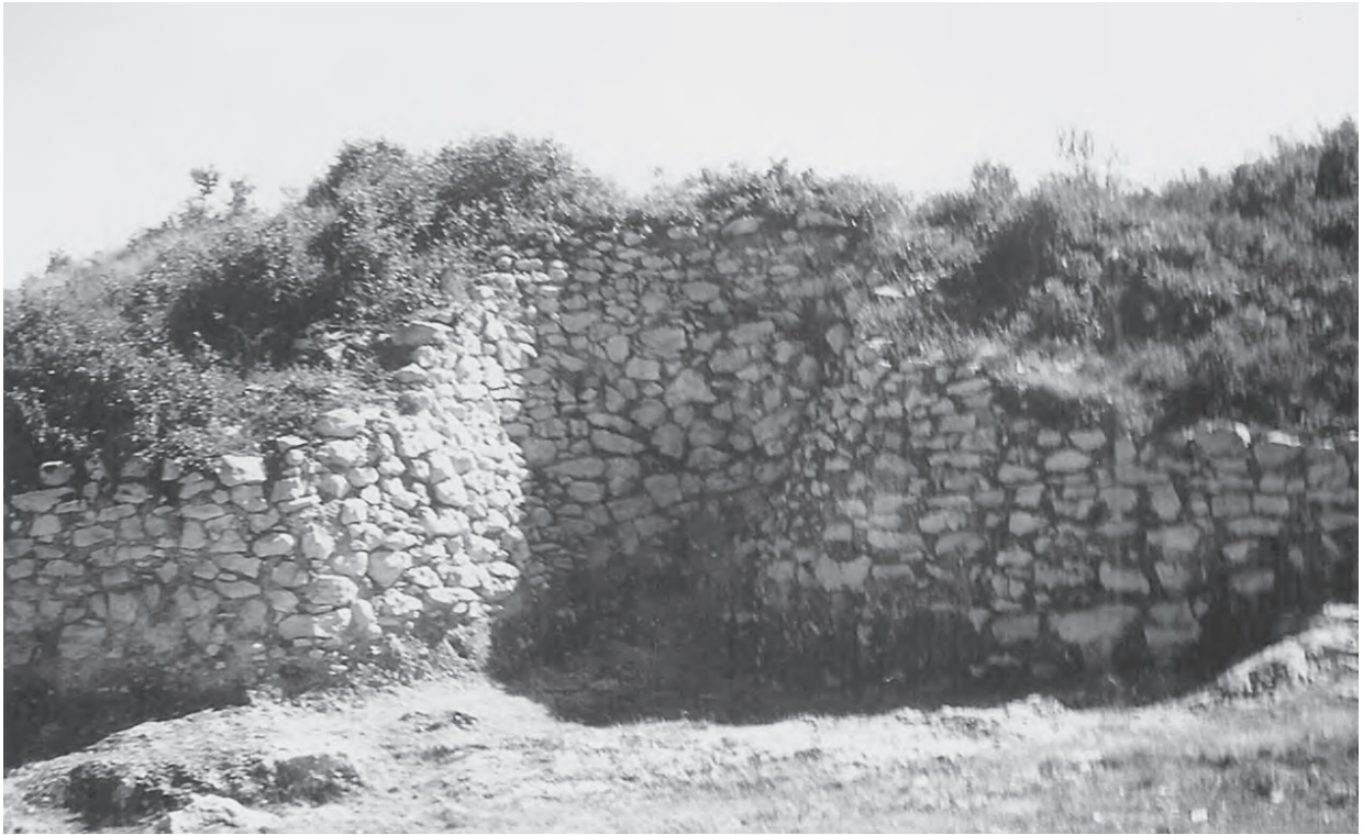
Fig. 8 – Vista parcial de norte da fortificação interna da VNSP, evidenciando-se dois dos bastiões maciços que a integram. Arquivo de O. da Veiga Ferreira/João Luís Cardoso.
