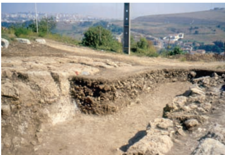
Fig. 46 – Leceia, Oeiras. Vista parcial do fosso ali identificado, entrosado no dispositivo defensivo constituído por muralhas pétreas, constituindo um raro exemplo da coexistência das duas estratégias defensivas, no decurso do Calcolítico. Foto de J. L. Cardoso.
