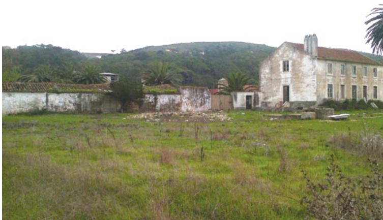
Fig. 2 – Vista de Noroeste da actual quinta de São Gião. Foto de Carlos Fidalgo. Em segundo plano, ao centro pode ver-se parte da cobertura metálica que ainda protege e esconde a igreja de São Gião (23.10.2015).
