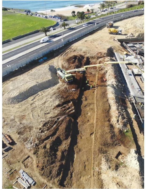
Fig. 5 – Vista aérea oblíqua da “vala 12”, observando-se a sua posição relativa ao mar, em último plano.
