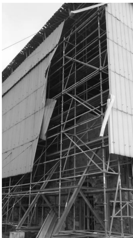
Fig. 12 – Estado actual da cobertura que deveria proteger a igreja dos factores climáticos. Note-se a existência de pilaretes de betão, fundados no terreno, nos quais se apoia a estrutura.
