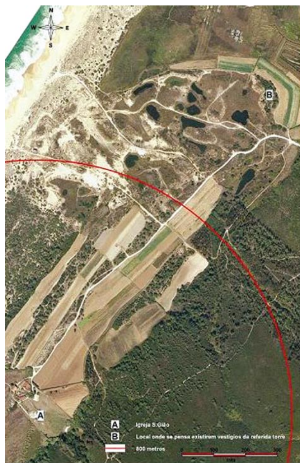
Fig. 3 – Em A localiza-se a igreja de São Gião. Em B assinala-se a possível localização da Torre referida por Frei Bernardo de Brito. (FIDALGO, 2013, p. 116). Foi possível verificar no local que, a existirem, os vestígios estariam debaixo de muito entulho que por ali se tem depositado.
