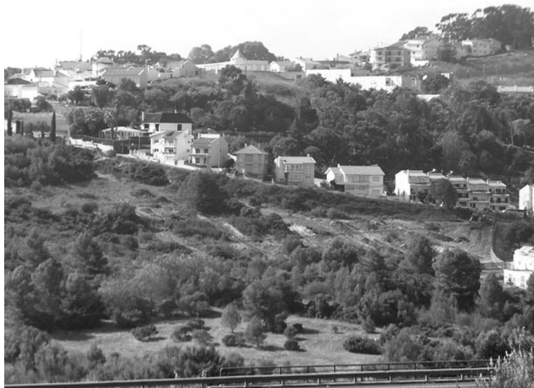
Fig. 3 – Vista geral dos trabalhos realizados, obtida do topo da encosta fronteira da ribeira de Barcarena. Foto JLC.
