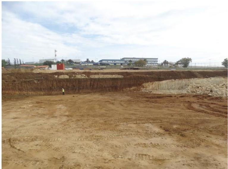
**Fig. 1** – Vista geral da plataforma com ligeiro pendor para SW, constituída pela acumulação de espesso conjunto sedimentar silto-argiloso, depositado em depressão natural do substrato calcário miocénico, visível do lado direito do corte.
