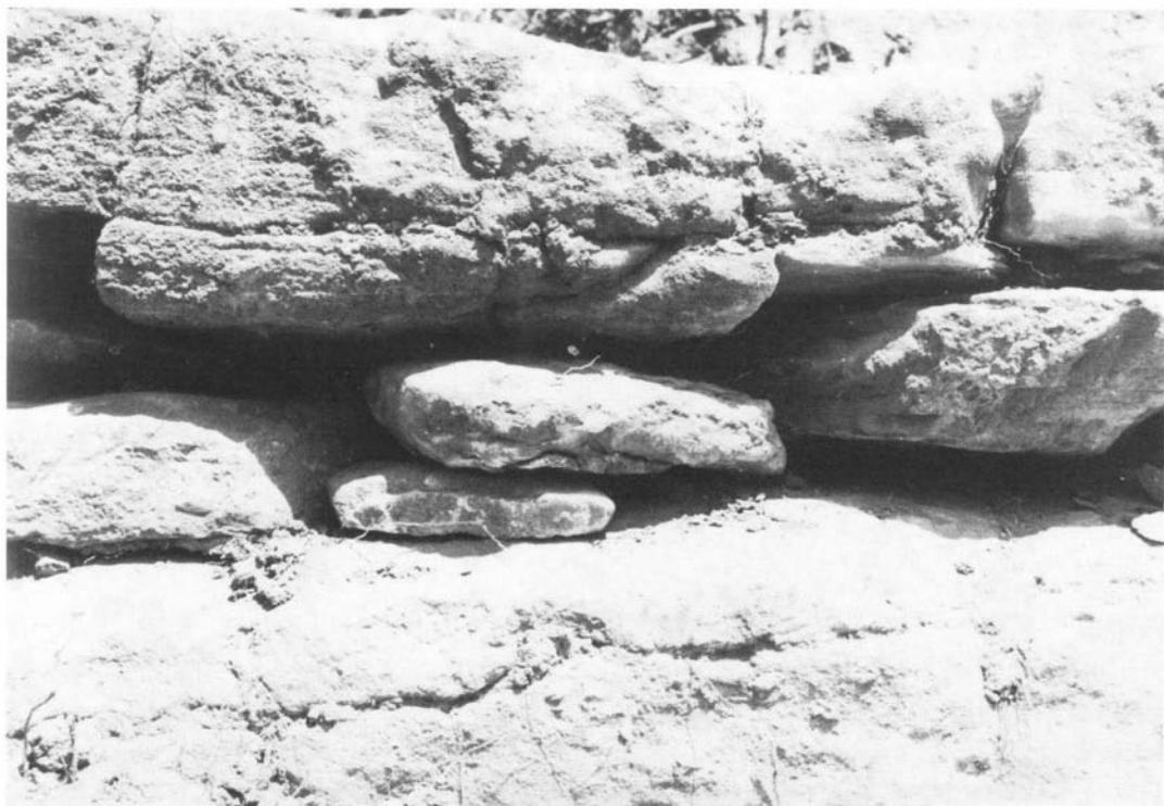
Fig. 22 – Tholos da Tituaría (1978). Pormenor do paramento inteiro da parede da câmara, evidenciando-se o aparelho de grandes blocos, travados por outros de menores dimensões, assentes no substrato geológico. Foto de M. Leitão.
