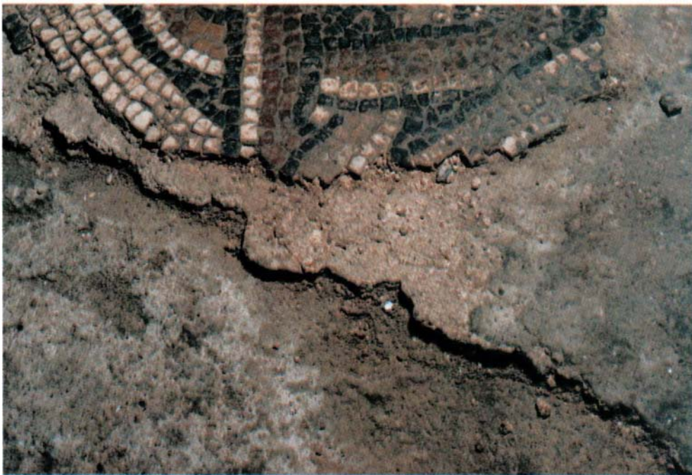
Fig. 11 – Mosaico de Oeiras. Aspecto do nucleus e da argamassa onde assentam as tesselas. Foto de B. Ferreira.
