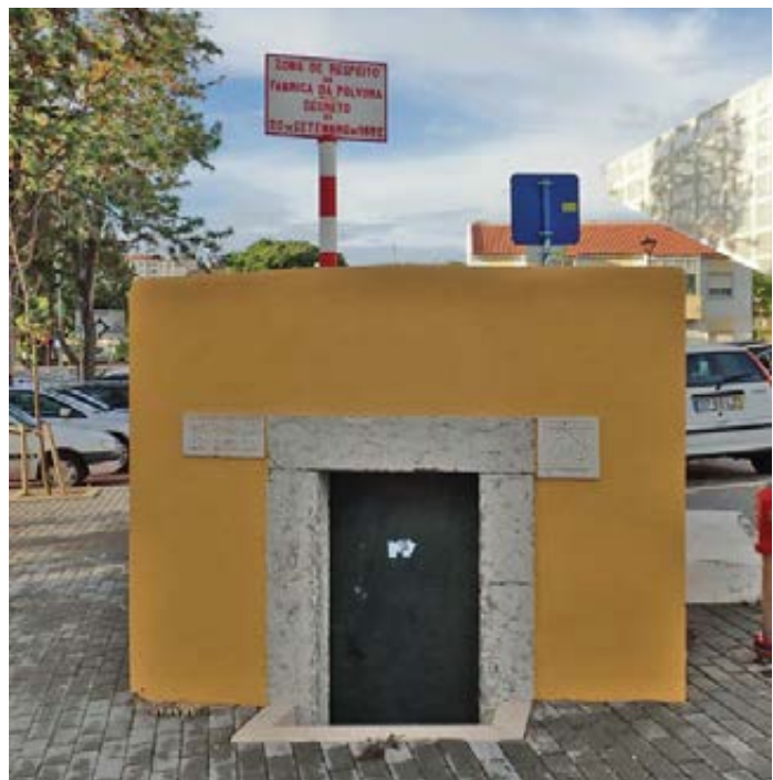
Fig. 18 – Entrada de uma mina do sistema de captações subterrâneas de alimentação da Fábrica da Pólvora de Barcarena, situada em Tercena. Do lado direito da imagem pode ver-se a placa de posse da propriedade, com a sigla PMB, Pólvora e Munições de Barcarena, acompanhada da placa de ferro fundido indicadora da “Zona de Respeito” da Fábrica. Foto de B. L. Ferreira.
