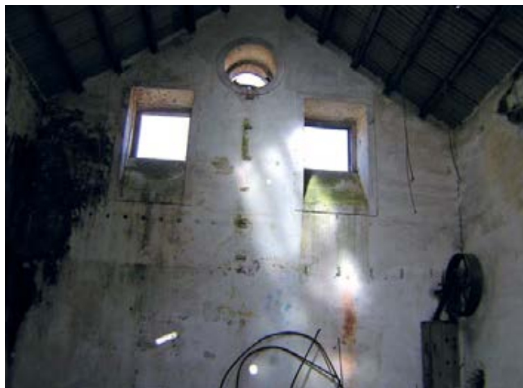
Fig. 43 – Vista interior de uma das oficinas da “Fábrica de Cima”, reproduzindo fielmente a arquitectura e dimensões das suas congéneres da “Fábrica de Baixo”. Note-se o assinalável pé direito do edifício para assegurar a expansão do ar na vertical, de baixo para cima, e em altura, em caso de explosão. Foto de J. L. Cardoso.
