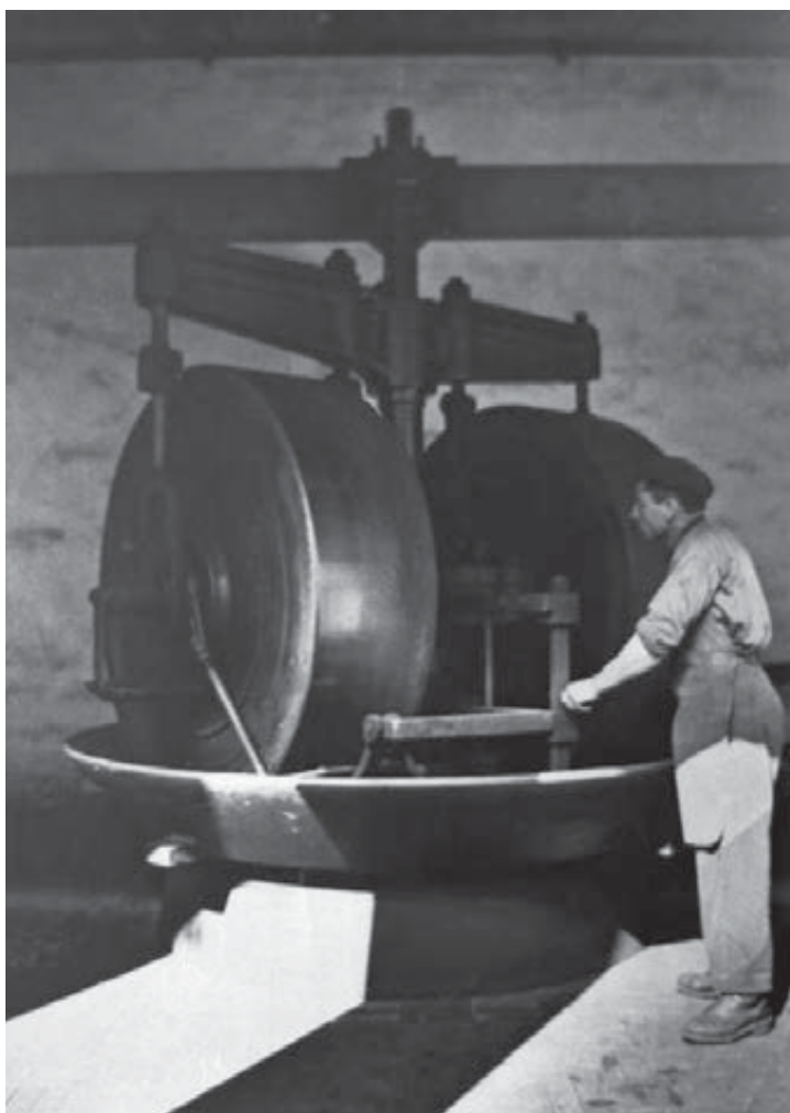
Fig. 51 – Galgas eléctricas de ferro fundido da fabrico alemão da década de 1920, podendo ler-se no pé dos pratos, de ferro fundido, a seguinte inscrição: FRIED. KRUPP AKT.GES. GRUSONWERK MAGDEBURG. Arquivo CMO. Reprodução fotográfica de J. L. Cardoso.
