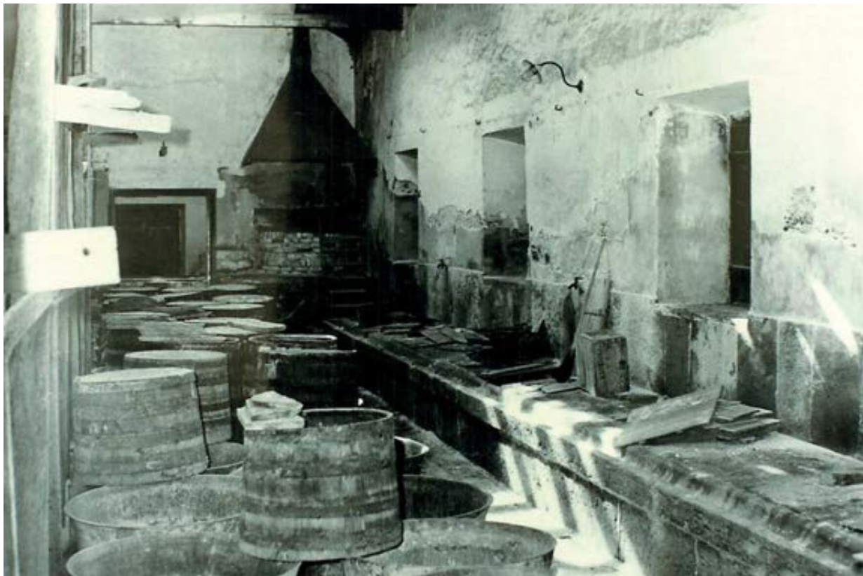
Fig. 28 – Oficina da refinação do salitre, já em ruína, situada na extremidade do complexo fabril, na margem esquerda da ribeira de Barcarena. Observam-se as tinas de bronze onde o aquecimento do líquido salitroso era realizado, em fornos situados nos cantos da oficina. Arquivo CMO. Reprodução fotográfica de J. L. Cardoso.
