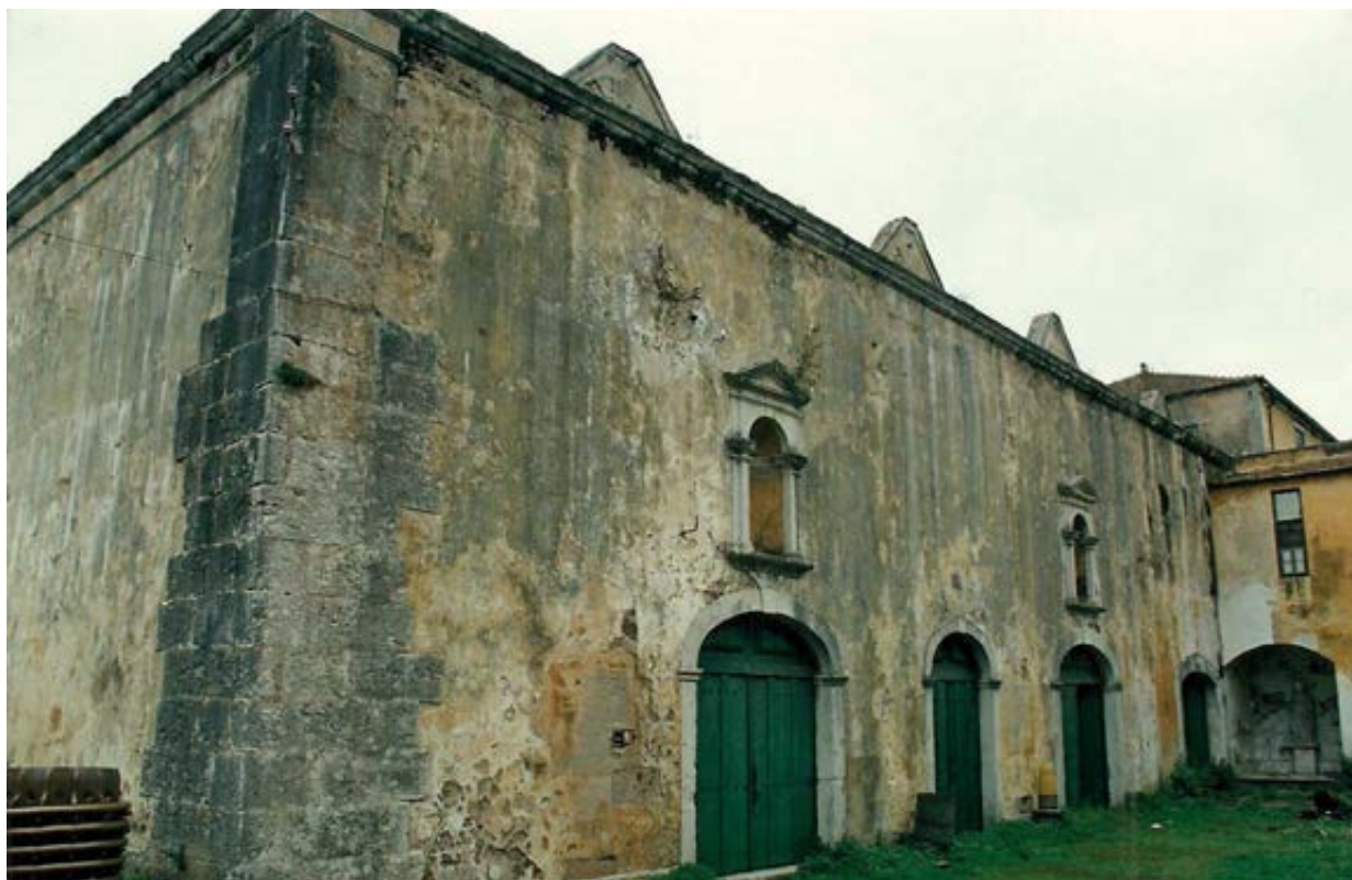
Fig. 1 – Fábrica da Pólvora de Barcarena. Vista do edifício onde se encontra presentemente instalado o Museu da Pólvora Negra. Foto de Rosário Almeida, Janeiro de 1995 (GC/CMO).
