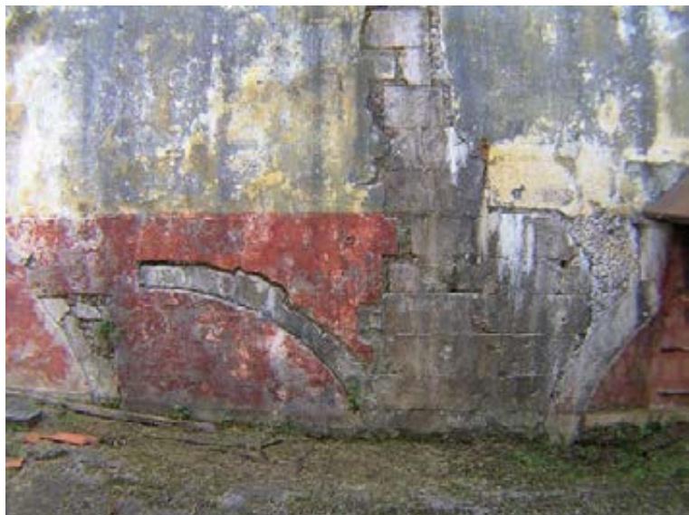
Fig. 5 – Parede setentrional do antigo edifício das Ferrarias evidenciando a existência de duas fases construtivas, a mais antiga correspondente à edificação e utilização do edifício como Ferrarias, a mais recente correspondente ao acrescento realizado no último quartel do século XVIII relacionado com a adaptação a fábrica a pólvora (a “Fábrica de Cima”). Nota-se a interrupção dos arcos relacionados com a localização das roda das azenhas das Ferrarias, pelos construídos no século XVIII e ainda o remate em excelente alvenaria aparelhada de blocos calcários do edifício das Ferrarias e do respectivo canal, depois acrescentado Foto de J. L. Cardoso.
