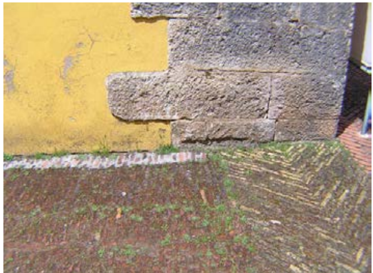
Fig. 76 – Pavimento constituído por tijolos colocados de cutelo, em espinha, para evitar o risco de faíscas, conservado no corredor circundante da “Fábrica de Baixo”. Foto de J. L. Cardoso.
