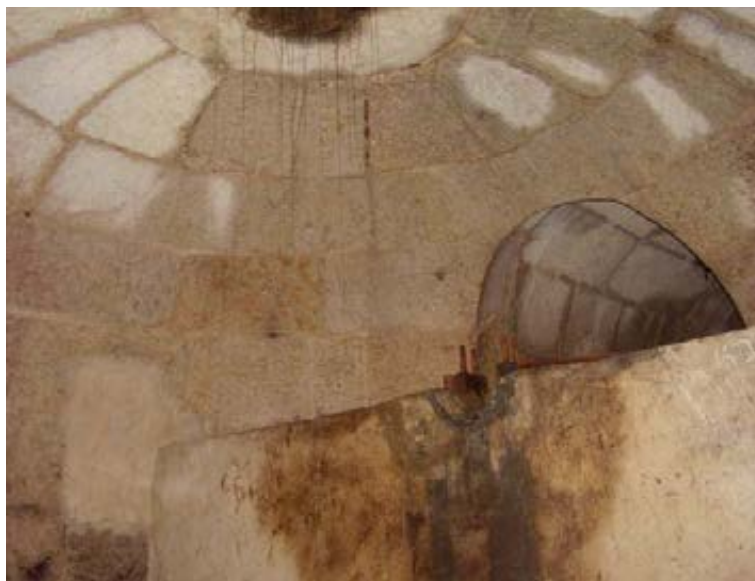
Fig. 41 – Vista parcial da abóbada de alvenaria aparelhada de calcário de uma das câmaras subterrâneas da “Fábrica de Cima”, em tudo idênticas às da “Fábrica de Baixo”. Observa-se do lado direito da foto a abóbada que comunicava com a galeria subjacente ao canal, onde se alojava o veio horizontal do engenho apoiado em chumaceira aberta em bloco de cimento mais moderno. No fecho da abóbada observa-se a abertura de saída do eixo rotativo vertical que transmitia o movimento às galgas, situadas no piso térreo do edifício. Foto de F. Martins.
