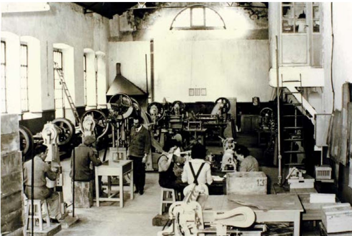
Fig. 69 – Oficina de latoaria instalada em edifício do primeiro quartel do século XX. Note-se a presença de operariado feminino. Arquivo CMO. Reprodução fotográfica de J. L. Cardoso.
