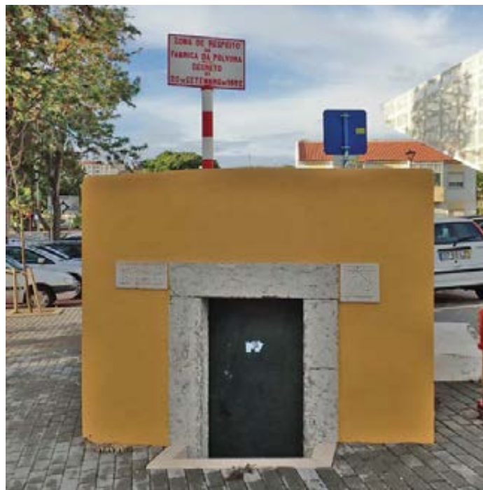
Fig. 18 – Entrada de uma mina do sistema de captações subterrâneas de alimentação da Fábrica da Pólvora de Barcarena, situada em Tercena. Do lado direito da imagem pode ver-se a placa de posse da propriedade, com a sigla PMB, Pólvora e Munições de Barcarena, acompanhada da placa de ferro fundido indicadora da “Zona de Respeito” da Fábrica. Foto de B. L. Ferreira.
