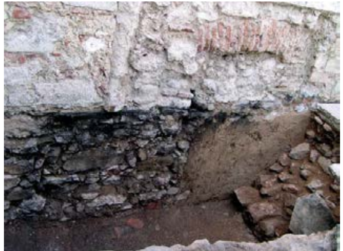
Fig. 85 – Pormenor da intervenção arqueológica dirigida pelo signatário em 2009 no edifício das Ferrarias, evidenciando-se o fecho da antiga porta das mesmas, entulhada aquando da adaptação do espaço a Fábrica da Pólvora, sob a direcção de Bartolomeu da Costa, no último quartel do século XVIII. Foto de J. L. Cardoso.
