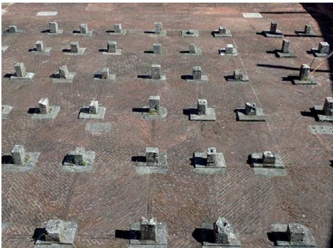
Fig. 38 – Foto dos pilaretes de sustentação dos tabuleiros para a secagem da pólvora no Pátio do Enxugo na actualidade. Foto de B. L. Ferreira.
