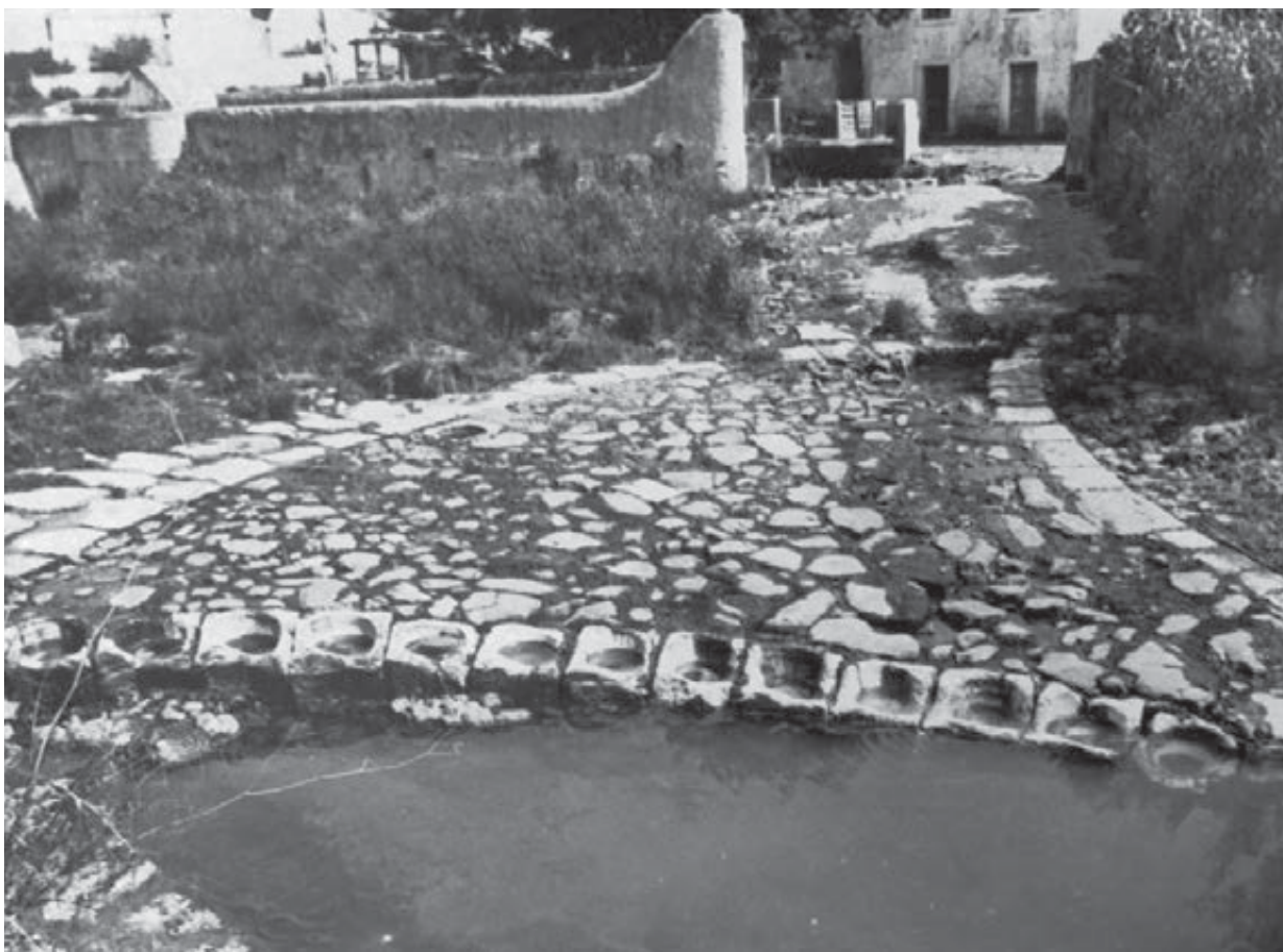
Fig. 12 – Alinhamento de almofarizes de calcário branco sub-cristalino, outrora observado na margem da ribeira de Barcarena a montante das Ferrarias e imediatamente a jusante do açude ali existente, actualmente desaparecidos. Correspondem à antiga Fábrica da Pólvora de pilões, da primeira metade do século XVII ou ainda do século anterior, a qual fica deste modo inequivocamente localizada. Foto antiga, arquivo CMO. Reprodução fotográfica de J. L. Cardoso.
