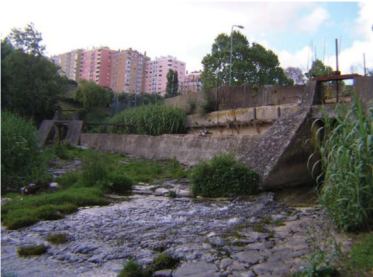
Fig. 17 – Aspecto do açude existente a montante, de derivação da água para o tanque existente na “Fábrica de Cima”. Observam-se as duas descargas de água, junto de ambas as margens. Foto de J. L. Cardoso.
