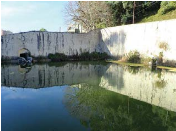
Fig. 20 – Bica de saída da água oriunda de captações subterrâneas do tanque da “Fábrica de Cima”, do último quartel do século XVIII, situada do lado direito da foto. Ao fundo, em frente, observa-se bica de maiores dimensões, relacionada com a água desviada da ribeira de Barcarena a montante, através de um açude (ver Fig. 17). Foto de B. L. Ferreira.
