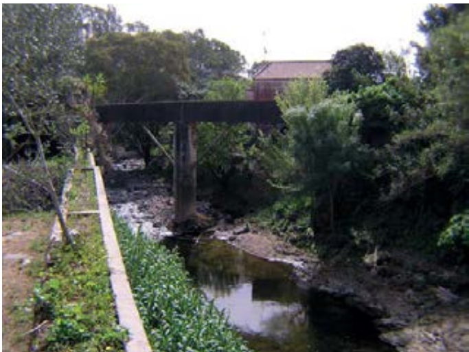
Fig. 49 – Ponte-canal a céu aberto, atravessando a ribeira de Barcarena, para alimentar a central hidroelétrica de 1925, situada na margem direita, cerca de 700 m a jusante, com água oriunda do tanque da “Fábrica de Cima”. Foto de J. L. Cardoso.
