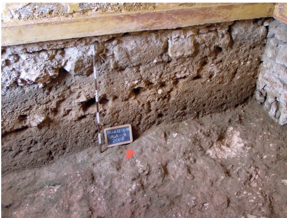
Fig. 9 – Sala 4. Corte estratigráfico observado ao longo da parede setentrional da sala, observando-se do lado direito o embasamento de parede mestra, fundada no substrato geológico, do edifício de origem setecentista. O enchimento terroso, sobre o qual assenta parede divisória do piso térreo do edifício, marcada por uma régua de madeira correspondente ao antigo rodapé, contém materiais de todas as épocas e é posterior à fundação da parede mestra do edifício, podendo assim ser datado do século XIX. (foto de João Luís Cardoso).
