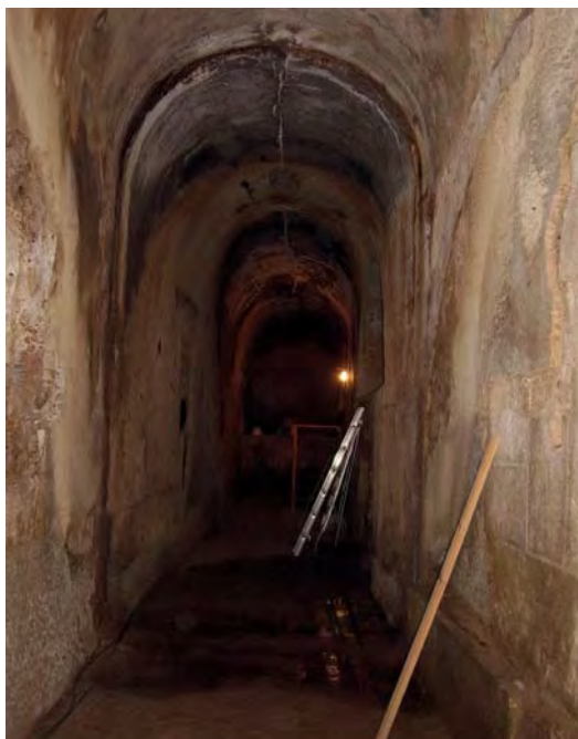
Fig. 6 – Vista do interior da galeria do edifício das Ferrarias, observando-se o prolongamento da galeria das Ferrarias relacionado com a ampliação efectuada no último quartel do século XVIII, com orientação ligeiramente distinta. Foto de F. Martins.
