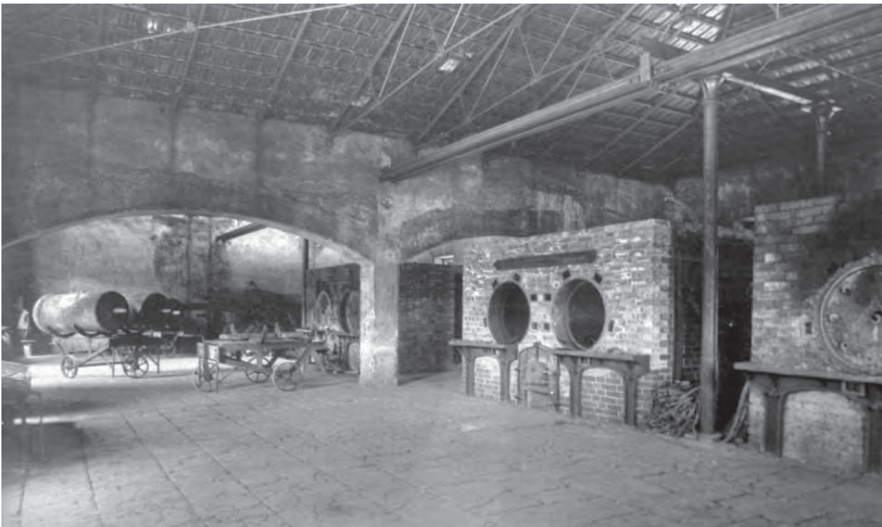
Fig. 33 – Oficina de carbonização instalada na margem direita da ribeira de Barcarena no século XIX. Foto antiga, arquivo CMO. Reprodução fotográfica de J. L. Cardoso.
