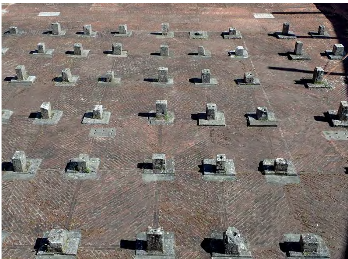
Fig. 38 – Foto dos pilaretes de sustentação dos tabuleiros para a secagem da pólvora no Pátio do Enxugo na actualidade. Foto de B. L. Ferreira.
