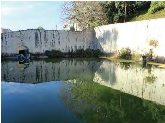
Fig. 20 – Bica de saída da água oriunda de captações subterrâneas do tanque da “Fábrica de Cima”, do último quartel do século XVIII, situada do lado direito da foto. Ao fundo, em frente, observa-se bica de maiores dimensões, relacionada com a água desviada da ribeira de Barcarena a montante, através de um açude (ver Fig. 17). Foto de B. L. Ferreira.
