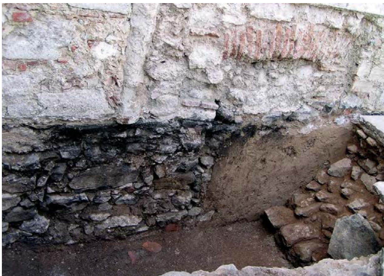
Fig. 85 – Pormenor da intervenção arqueológica dirigida pelo signatário em 2009 no edifício das Ferrarias, evidenciando-se o fecho da antiga porta das mesmas, entulhada aquando da adaptação do espaço a Fábrica da Pólvora, sob a direcção de Bartolomeu da Costa, no último quartel do século XVIII. Foto de J. L. Cardoso.
