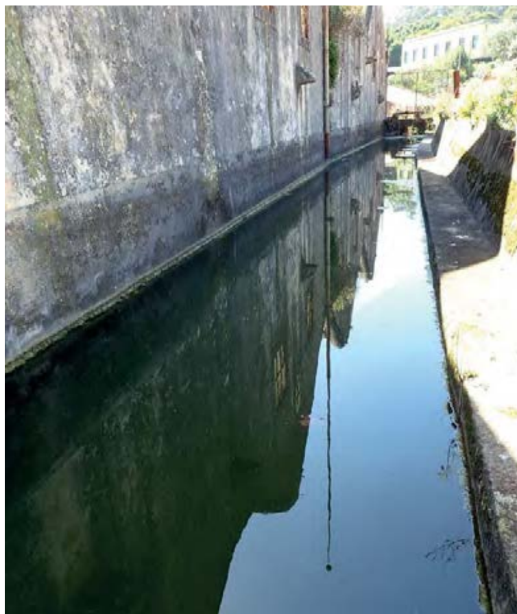
Fig. 44 – Canal exterior da “Fábrica de Cima”, alimentado pelo tanque adjacente. Foto de B. L. Ferreira.
