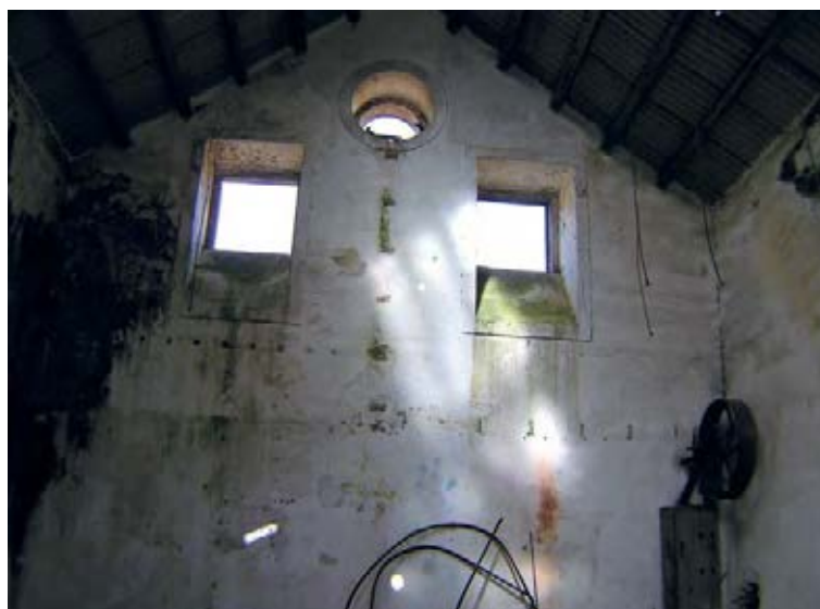
Fig. 43 – Vista interior de uma das oficinas da “Fábrica de Cima”, reproduzindo fielmente a arquitectura e dimensões das suas congéneres da “Fábrica de Baixo”. Note-se o assinalável pé direito do edifício para assegurar a expansão do ar na vertical, de baixo para cima, e em altura, em caso de explosão. Foto de J. L. Cardoso.
