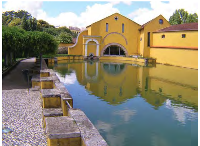
Fig. 21 – Vista actual do tanque da “Fábrica de Baixo”, com falta de gárgula por onde saía a água, vendida em 1976 em hasta pública a particular. Foto de J. L. Cardoso.
