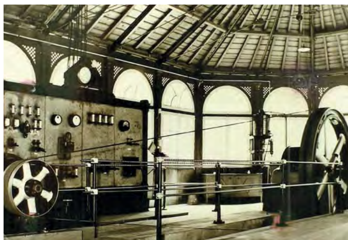
Fig. 47 – Central de produção de energia eléctrica de 1924, a partir de um motor Diesel DEUTZ. Foto antiga, arquivo CMO. Reprodução fotográfica de J. L. Cardoso.
