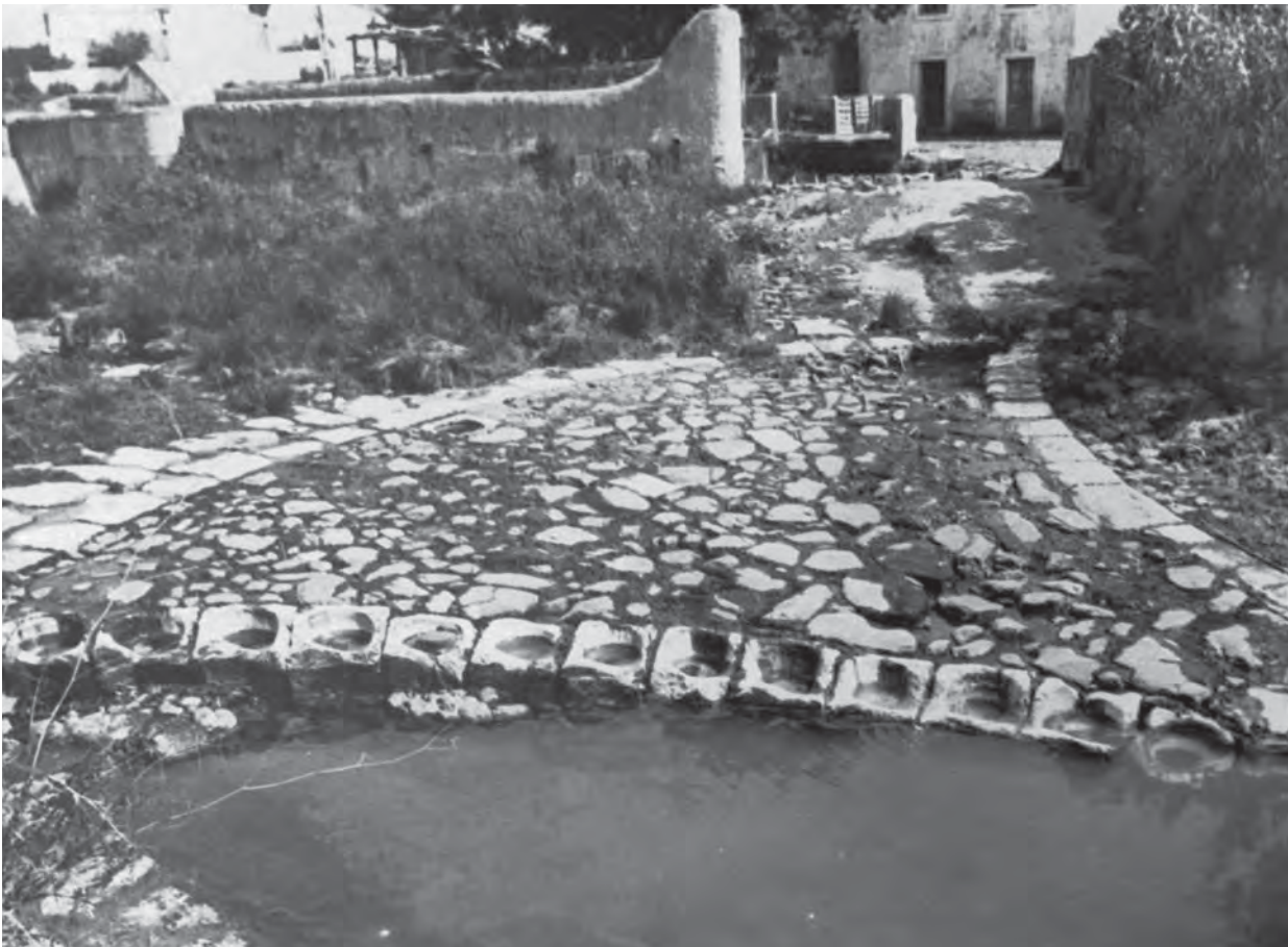
Fig. 12 – Alinhamento de almofarizes de calcário branco sub-cristalino, outrora observado na margem da ribeira de Barcarena a montante das Ferrarias e imediatamente a jusante do açude ali existente, actualmente desaparecidos. Correspondem à antiga Fábrica da Pólvora de pilões, da primeira metade do século XVII ou ainda do século anterior, a qual fica deste modo ali inequivocamente localizada. Foto antiga, arquivo CMO. Reprodução fotográfica de J. L. Cardoso.
