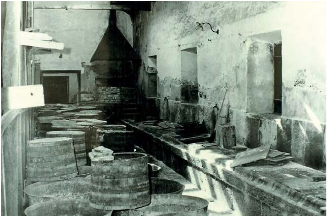
Fig. 28 – Oficina da refinação do salitre, já em ruína, situada na extremidade do complexo fabril, na margem esquerda da ribeira de Barcarena. Observam-se as tinas de bronze onde o aquecimento do líquido salitroso era realizado, em fornos situados nos cantos da oficina. Foto antiga, arquivo CMO. Reprodução fotográfica de J. L. Cardoso.
