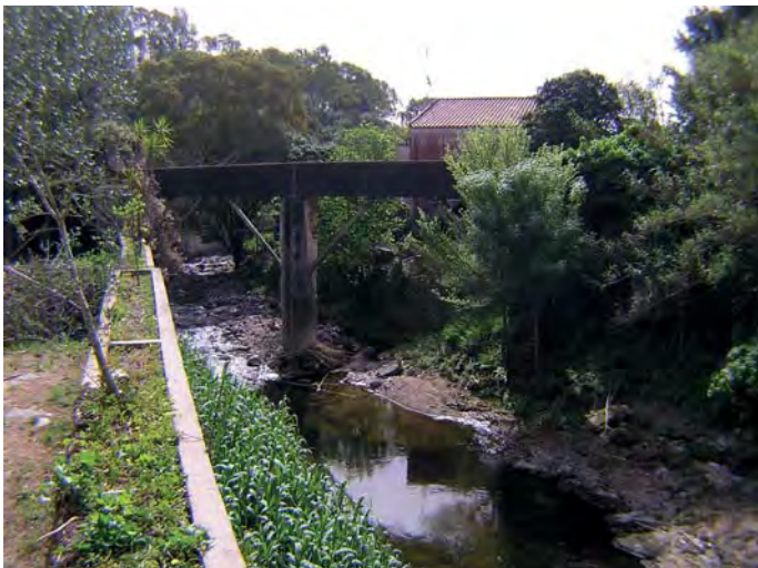
Fig. 49 – Ponte-canal a céu aberto, atravessando a ribeira de Barcarena, para alimentar a central hidroeléctrica de 1925, situada na margem direita, cerca de 700 m a jusante, com água oriunda do tanque da “Fábrica de Cima”. Foto de J. L. Cardoso.
