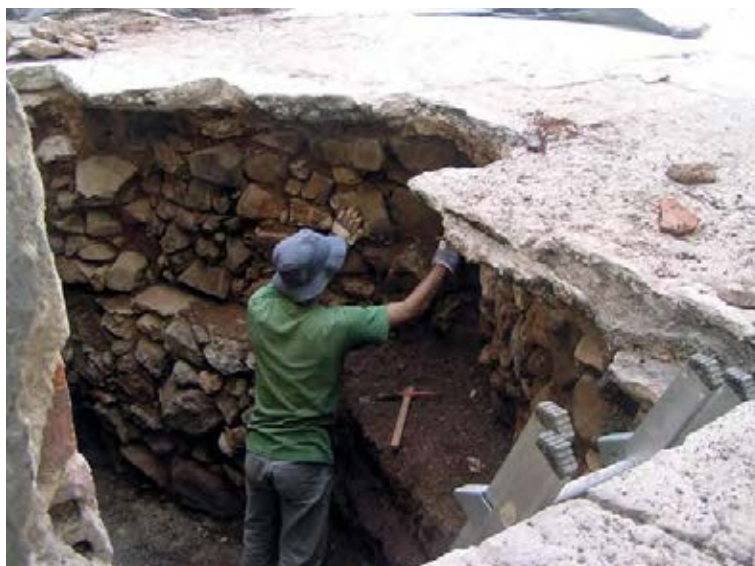
Fig. 7 – Vista parcial da escavação efectuada no edifício das Ferrarias em 2009, sob direcção do signatário. Observa-se a parede externa da abóbada de uma das câmaras enterradas onde se instalaram os maquinismos de transmissão de movimento às galgas, sob o piso lajeado então construído. Foto de J. L. Cardoso.
