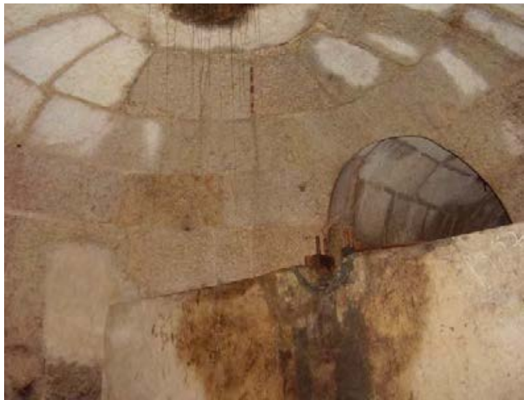
Fig. 41 – Vista parcial da abóbada de alvenaria aparelhada de calcário de uma das câmaras subterrâneas da “Fábrica de Cima”, em tudo idênticas às da “Fábrica de Baixo”. Observa-se do lado direito da foto a que comunicava com a galeria subjacente ao canal, onde se alojava o veio horizontal do engenho apoiado em chumaceira aberta em bloco de cimento mais moderno. No fecho da abóbada observa-se a abertura de saída do eixo rotativo vertical que transmitia o movimento às galgas, situadas no piso térreo do edifício. Foto de F. Martins.
