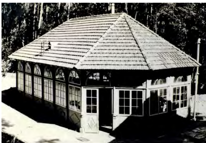
Fig. 46 – Edifício onde se encontrava instalada a central de produção de energia eléctrica de 1924, hoje pertença de particular. Foto antiga, arquivo CMO. Reprodução fotográfica de J. L. Cardoso.
