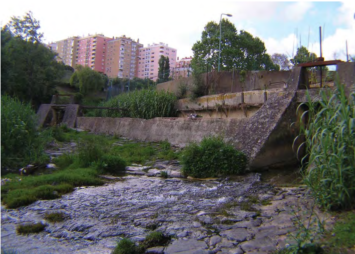
Fig. 17 – Aspecto do açude existente a montante na ribeira de Barcarena, de derivação da água para o tanque existente na “Fábrica de Cima”. Observam-se as duas descargas de água, junto de ambas as margens. Foto de J. L. Cardoso.
