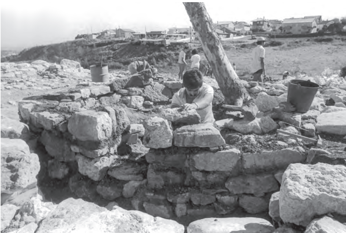
Fig. 335 – Leceia. Pormenor dos trabalhos de consolidação e restauro de estruturas arqueológicas efectuados em 1988.
