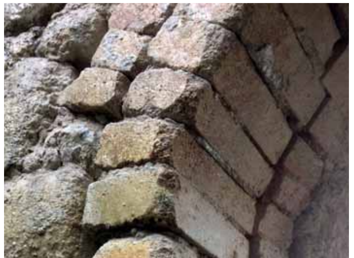
Fig. 9 e 10 – Interior do Forno B 1 (pedra e barro) e Interior do forno RO 6 (tijolo refratário). Fotos do autor, 2018.
