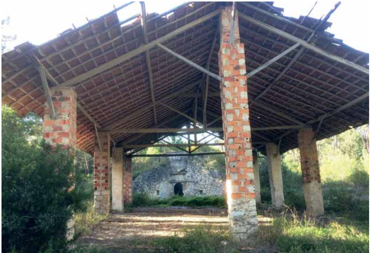
Fig. 14 – Barracão e forno de cal B 17. Foto do autor.
