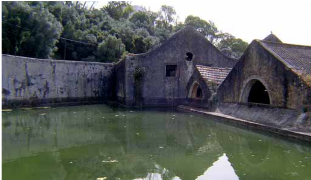
Fig. 35 – Vista parcial do tanque de água da “Fábrica de Cima”, projectado e construído por Bartolomeu da Costa no último quartel do século XVIII. Foto de B. L. Ferreira.
