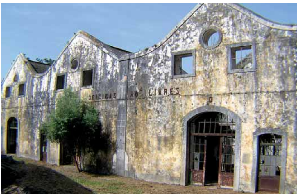
Fig. 34 – Vista parcial da fachada principal da “Fábrica de Cima”, projectada e construída por Bartolomeu da Costa no último quartel do século XVIII. Foto de J. L. Cardoso.
