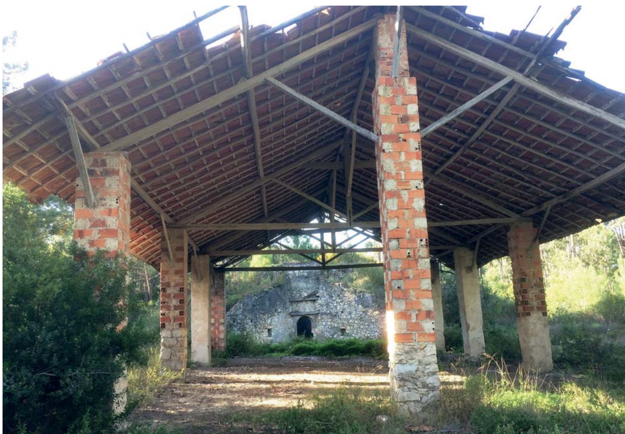
Fig. 14 – Barracão e forno de cal B 17. Foto do autor.
