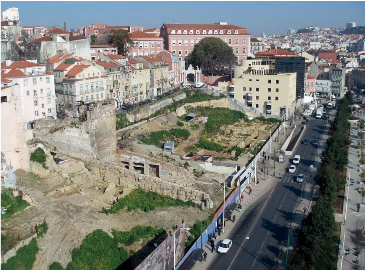
Fig. 2 – Encosta de Sant'Ana. Vista geral de intervenção arqueológica.
