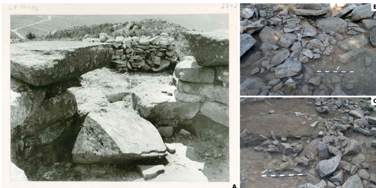
Fig. 12 – A) Estrutura pétrea tipo moroiço – Fotografia de Georg e Vera Leisner cedida pelo Arquivo Leisner/DGPC; B) – Derrube do corredor [16]; C) Derrube da estrutura de tipo moroiço.
