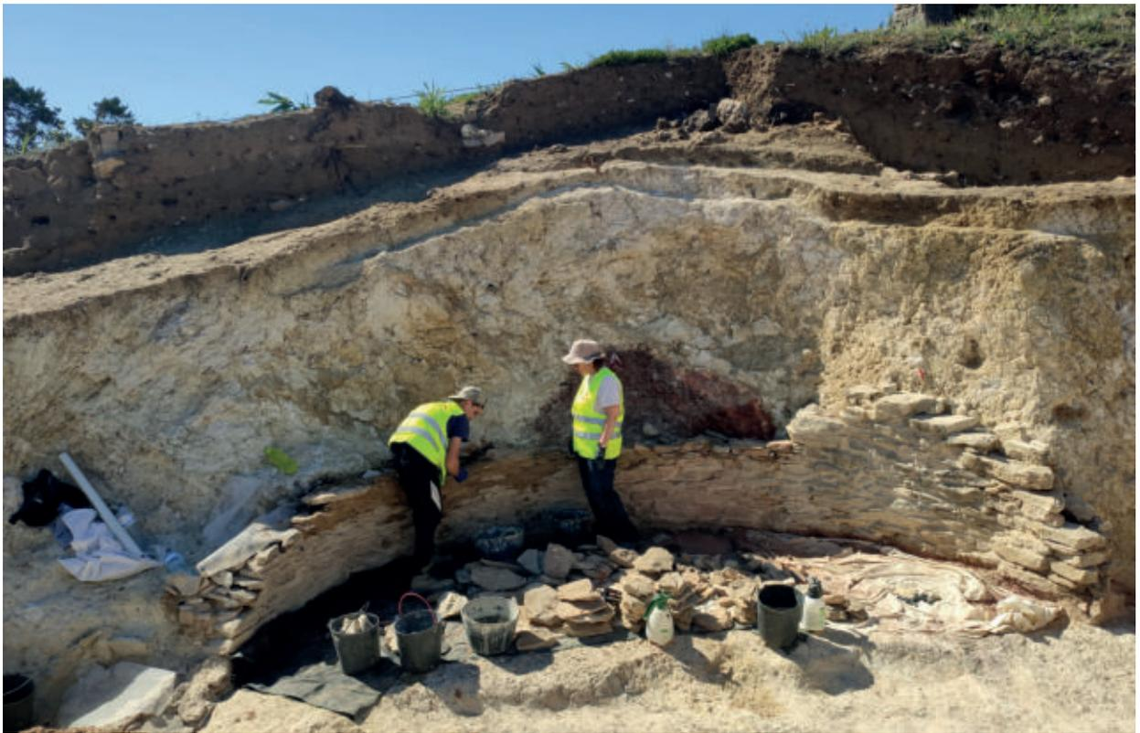
Fig. 39 – Trabalhos de conservação e restauro no muro sul da câmara central do *tholos*.
