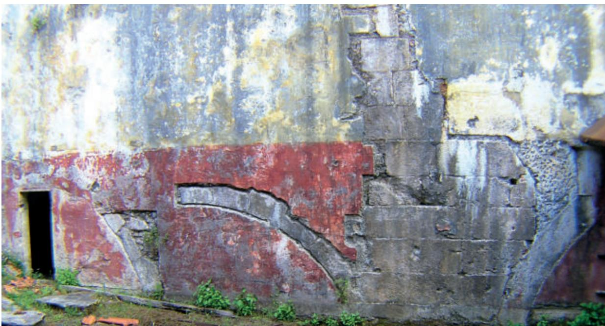
**Fig. 32** – Parede norte do antigo edifício das Ferrarias evidenciando a existência de duas ou três fases construtivas, a mais antiga correspondente à sua construção no século XV e primeira remodelação no século XVI, as mais modernas correspondentes às alterações dos séculos XVII e XVIII. Note-se o forte remate de alvenaria aparelhada de blocos correspondente ao antigo canal dos engenhos antes da ampliação verificada no final do século XVIII. Foto de J. L. Cardoso.
