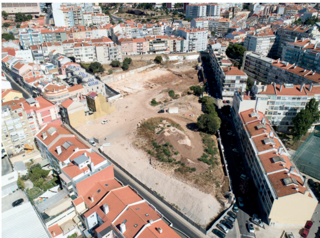
Fig. 3 – Rio Seco. Vista geral da área intervencionada na paisagem urbana envolvente para montante (Norte).
