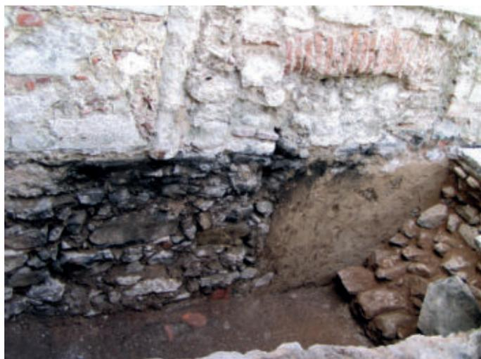
**Fig. 37** – Vista do fecho da porta das antigas Ferrarias, construída por tijoleiras colocadas de cutelo. Foto de J. L. Cardoso.
