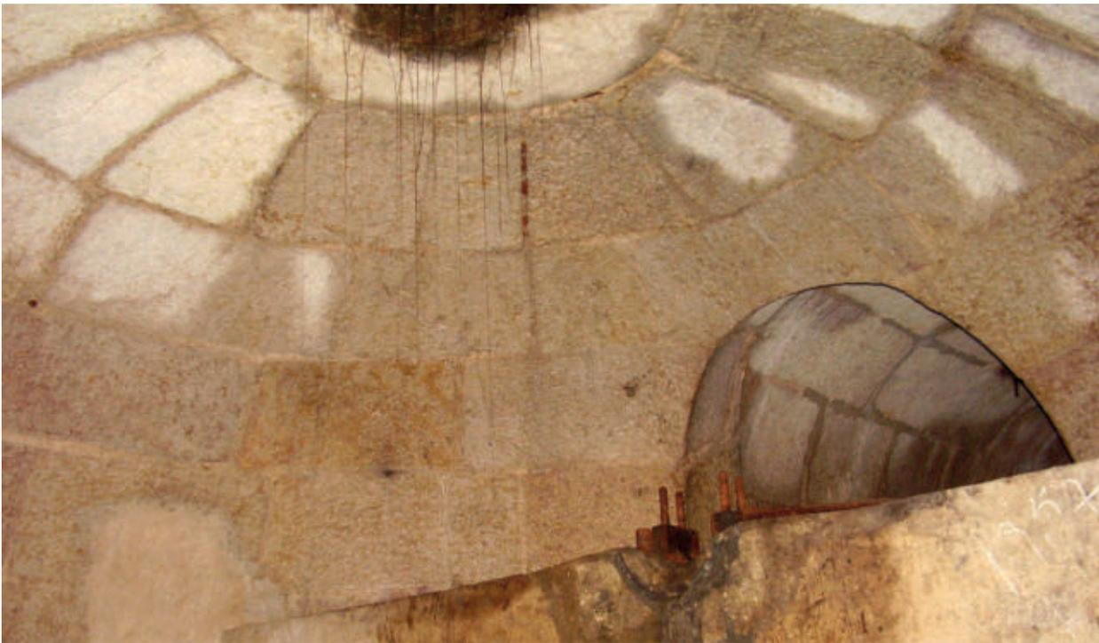
**Fig. 9** – Abóbada de alvenaria aparelhada de uma das quatro câmaras onde se alojavam os engenhos das galgas da fábrica da pólvora concebida e executada por Leonardo Turriano em 1618/1619. Foto de J. L. Cardoso.
