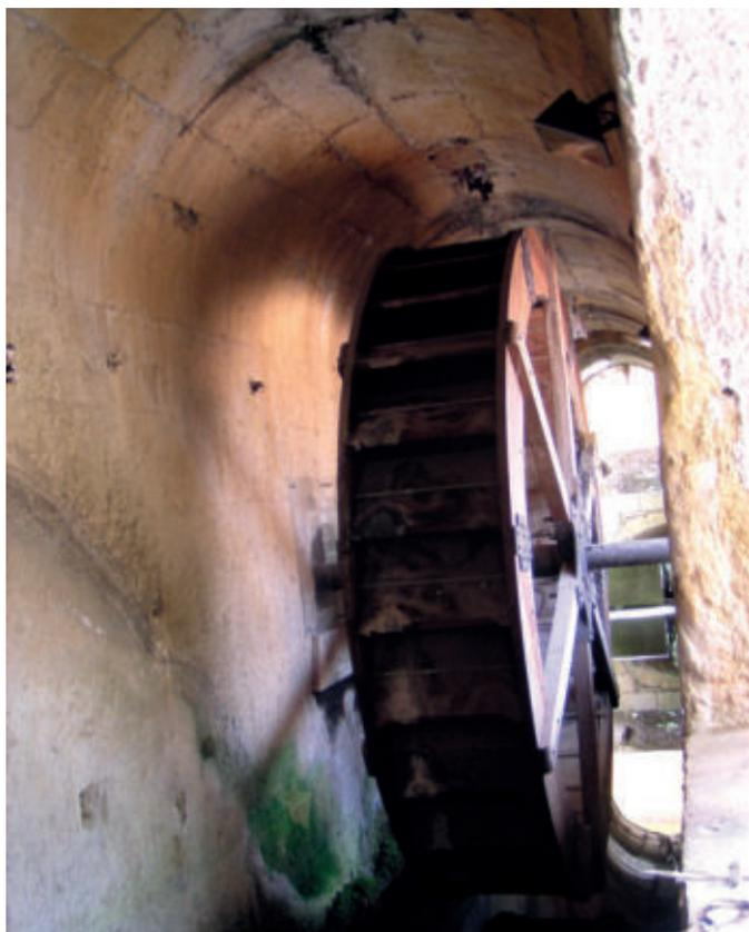
**Fig. 12** – Vista da galeria projectada e construída por Leonardo Turriano subjacente ao canal superior em que corria a água, na qual se encontravam alojadas as rodas das azenhas que faziam mover as galgas no interior do edifício. Observe-se a roda projectada por A. Quintela, J. L. Cardoso e J. M. Mascarenhas, e construída no âmbito da musealização do edifício, em 1998. Foto de J. L. Cardoso.
