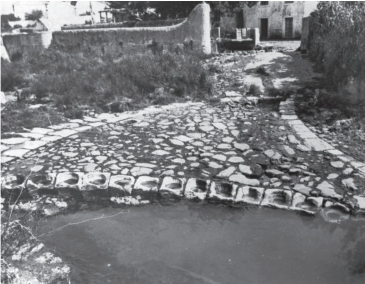
**Fig. 26** – Conjunto alinhado de almofarizes de calcário branco e duro, fotografado antes das grandes cheias verificadas na região de Lisboa em 1967 junto da margem esquerda da ribeira de Barcarena, a montante da Fábrica de Leonardo Turriano, indicadores da existência de uma antiga fábrica da pólvora utilizando o sistema de pilões. Foto da década de 1960. Arquivo da Câmara Municipal de Oeiras. reprodução de J. L. Cardoso.
