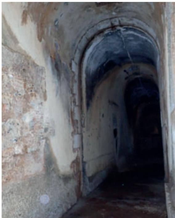
**Fig. 33** – Vista longitudinal da galeria das azenhas do edifício das Ferrarias, evidenciando-se a partir da junta, bem visível na foto, ligeira rectificação do seu traçado, resultante do acrescento verificado no final do século XVIII sob a égide do Tenente-General Bartolomeu da Costa. Foto de B. Ferreira.
