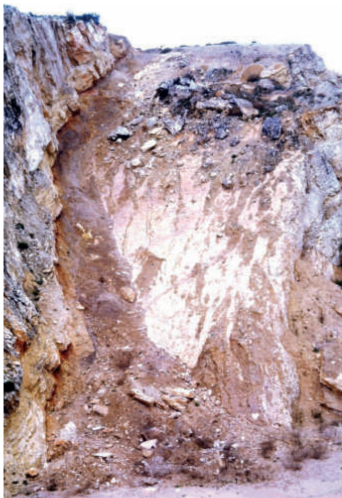
Fig. 1 - Deslizamento na frente da pedreira da Verdelha dos Ruivos, observado em fevereiro de 1973, pouco depois do abandono da exploração, e que proporcionou o seccionamento da gruta situada na parte superior da mesma. Arquivo JLC/OVF.
