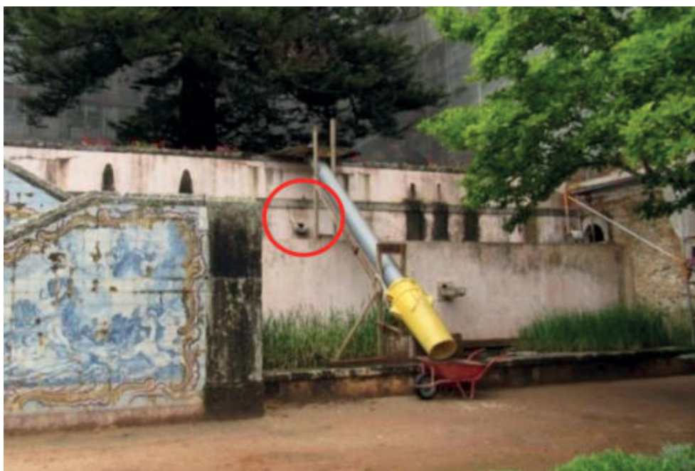
Fig. 24 – Pequena bica localizada no muro do Pátio das Araucárias.
