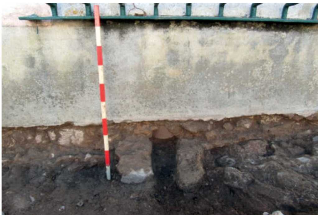
Fig. 18 – Algaroz [307] inserido na fachada Nordeste do Palácio.
