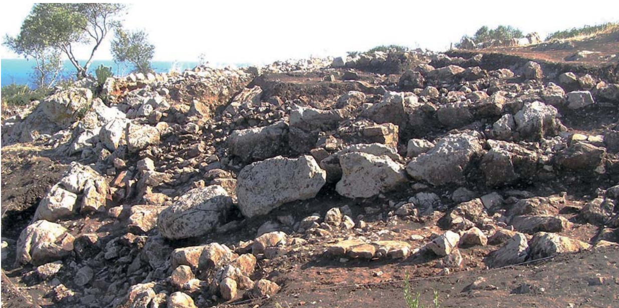
Fig. 32 – Outeiro Redondo. Vista frontal do remate nordeste do dispositivo defensivo, correspondente a barbacã definida por duas muralhas sub-paralelas, visíveis na fotografia (ver Fig. 30). Fotografia de João Luís Cardoso.
